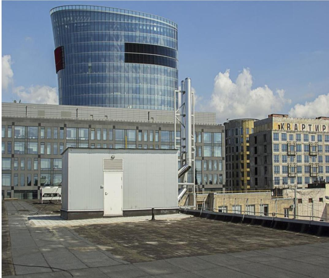
децентрализованные системы теплоснабжения, например с крышными котельными или индивидуальными котлами, установленными в каждой квартире жилого дома, ликвидирует потери связанные с транспортировкой и распределением теплоносителя и значительно снижает расход потребляемого топлива.
