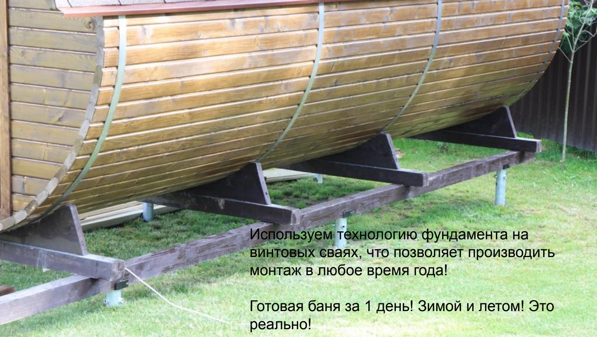
Используем технологию фундамента на винтовых сваях, что позволяет производить монтаж в любое время года!
