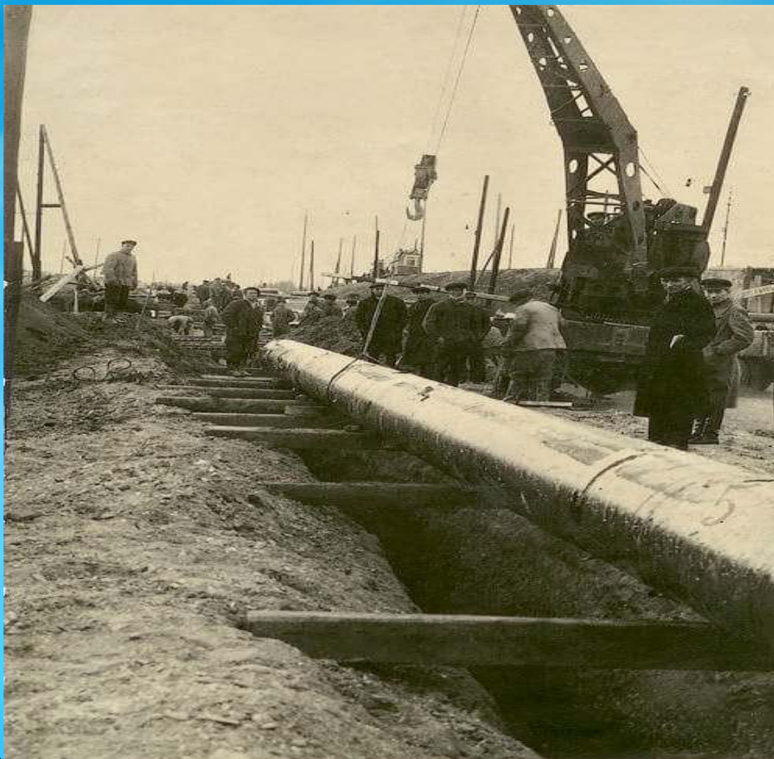
Строительство газового трубопровода Елшанка- Куйбышев.
