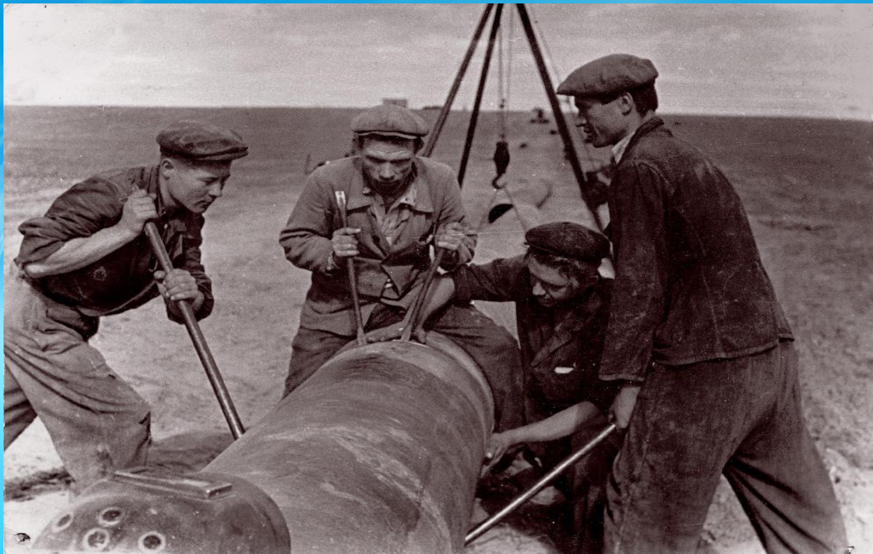
Строительство магистрального газопровода Саратов — Москва
