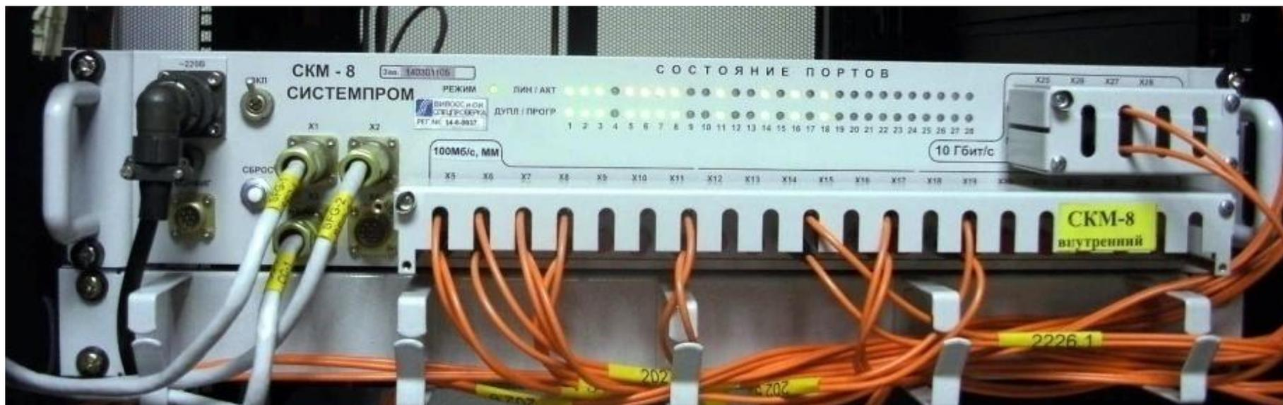
**Коммутатор СКМ-8** содержит 16 портов 10/100/1000Mbps и 8 портов для установки универсальных модулей SFP, является полнофункциональным управляемым коммутатором.
