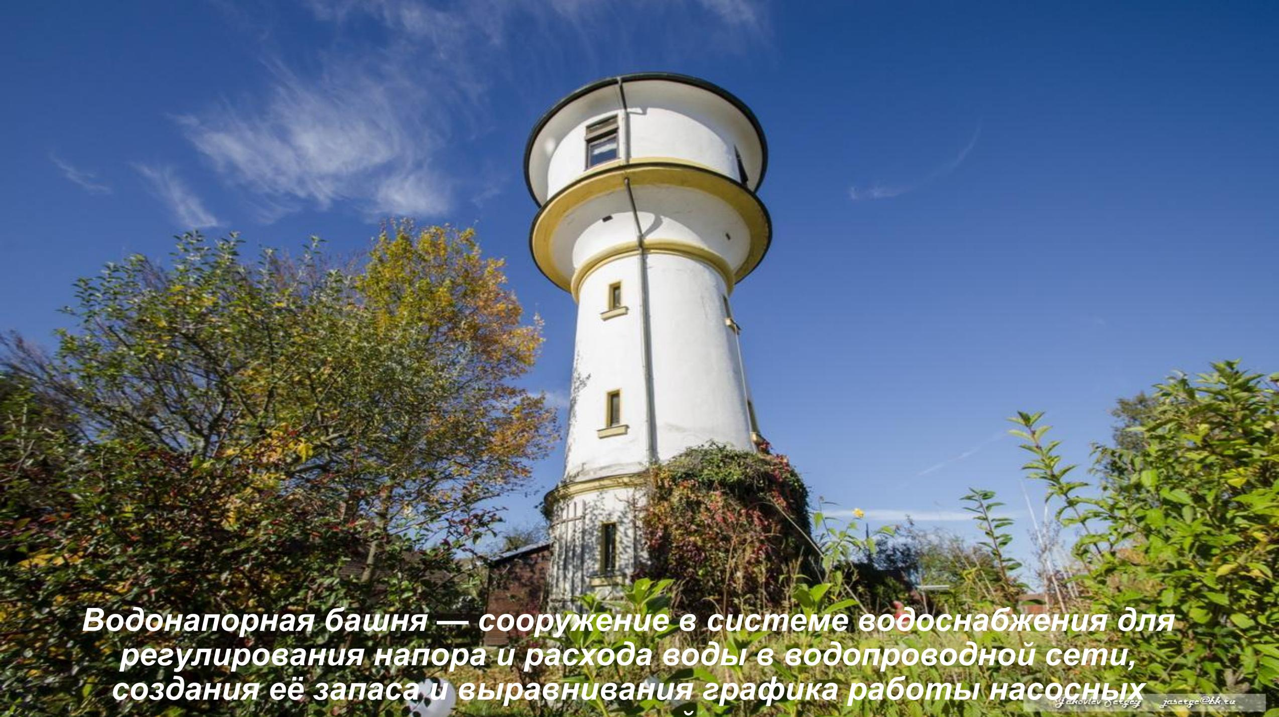
***Водонапорная башня — сооружение в системе водоснабжения для регулирования напора и расхода воды в водопроводной сети, создания её запаса и выравнивания графика работы насосных***
