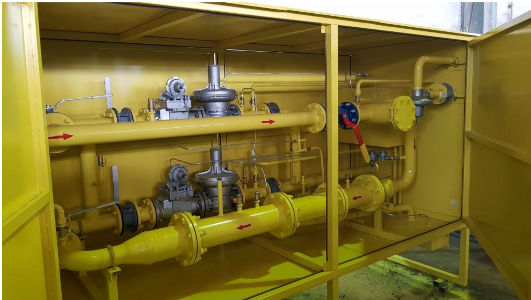
Газорегуляторный пункт
