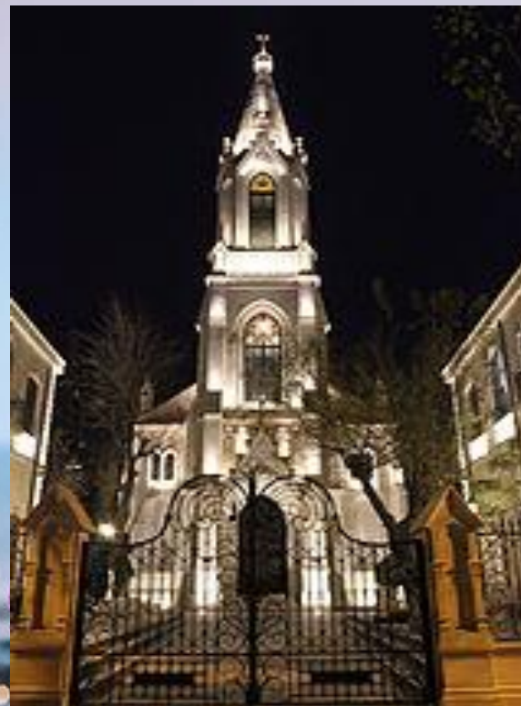
Здание Лютеранской Церкви в Баку.
