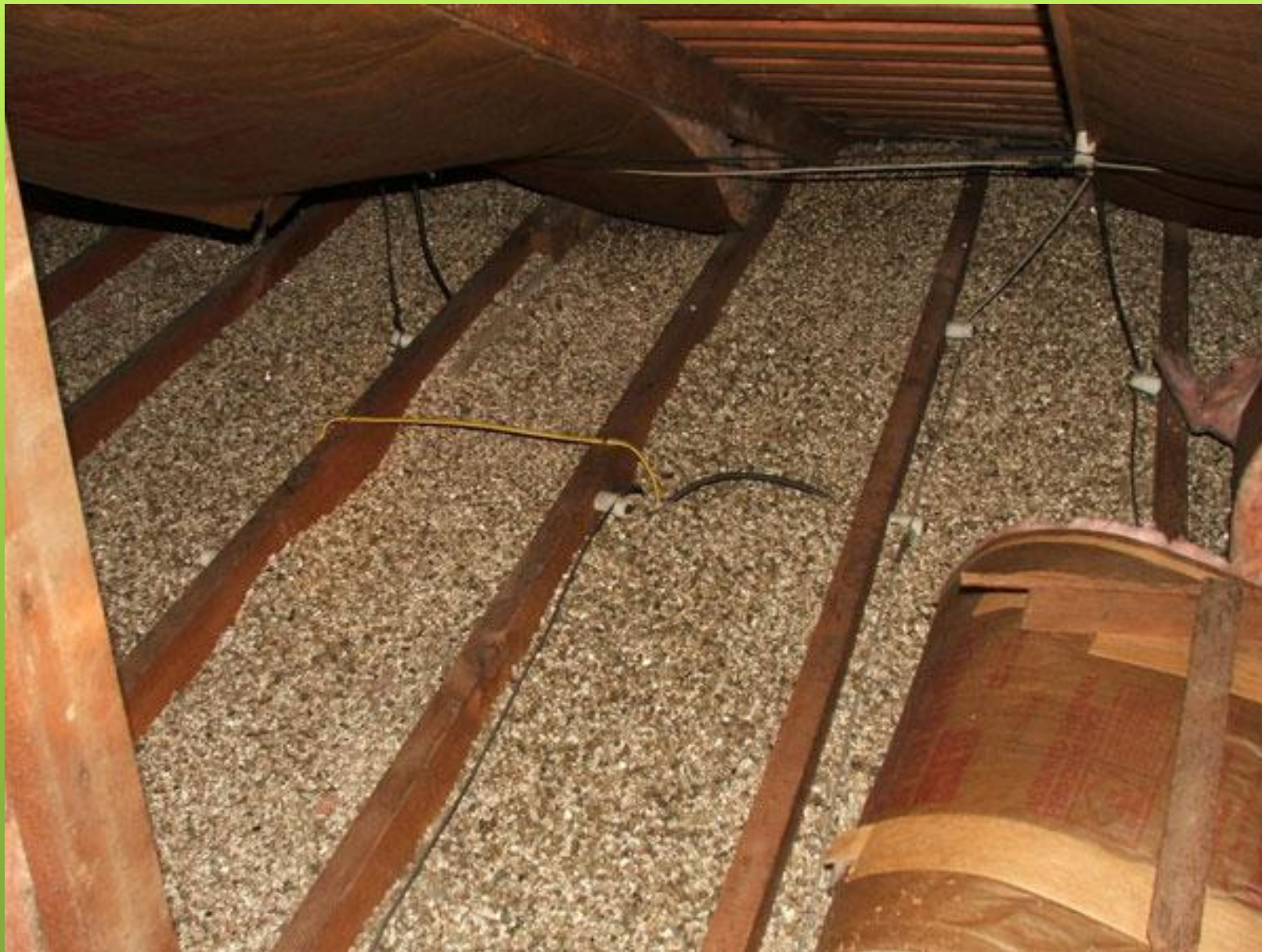
Засыпка вермикулита на чердачное перекрытие
