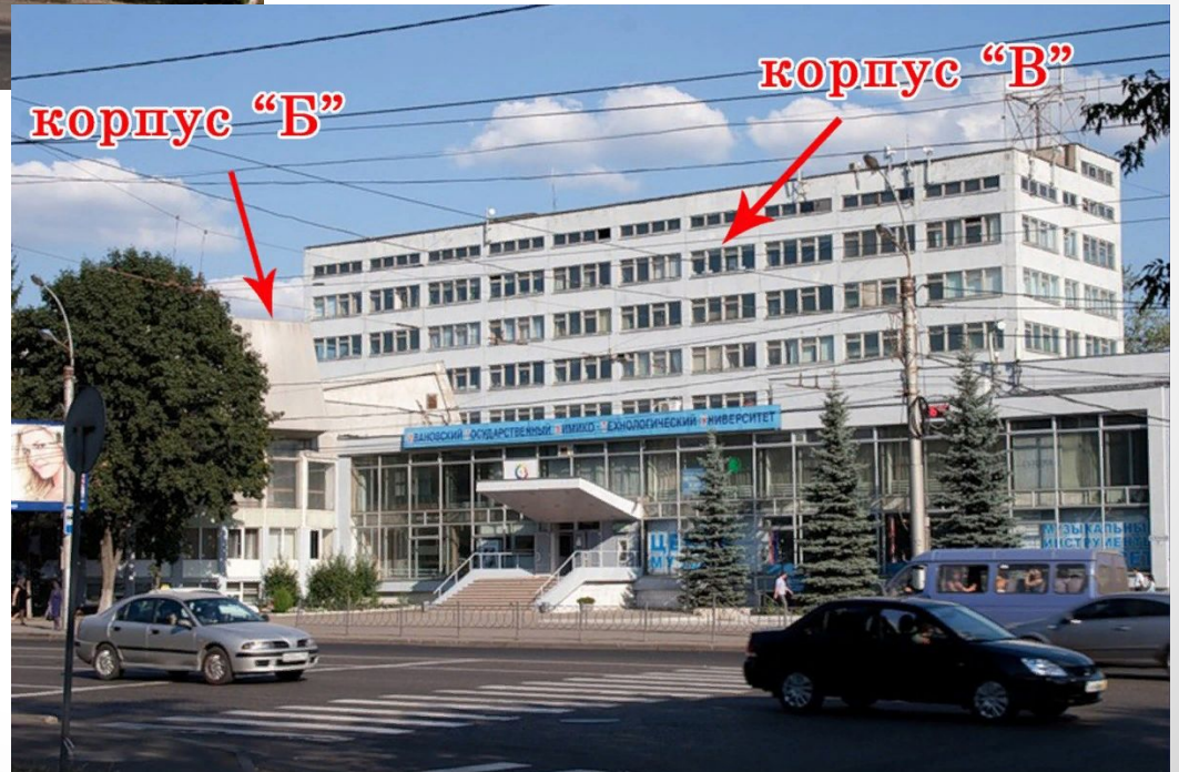
Bank «B» building and high-Rise «V»
