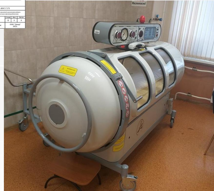
Подключение кислородопровода осуществляется к существующей системе кислородоснабжения здания; выброс использованного кислорода происходит наружу через гильзу в наружной стене. В разделе ИТО отражены решения по инженерным системам, необходимым для функционирования кабинета.
