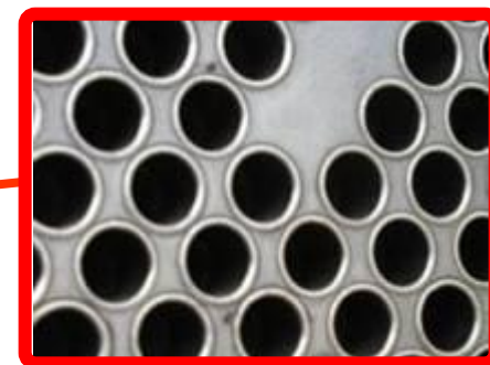
Орбитальная сварка трубок в трубных досках
