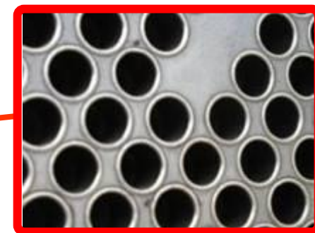
Орбитальная сварка трубок в трубных досках
