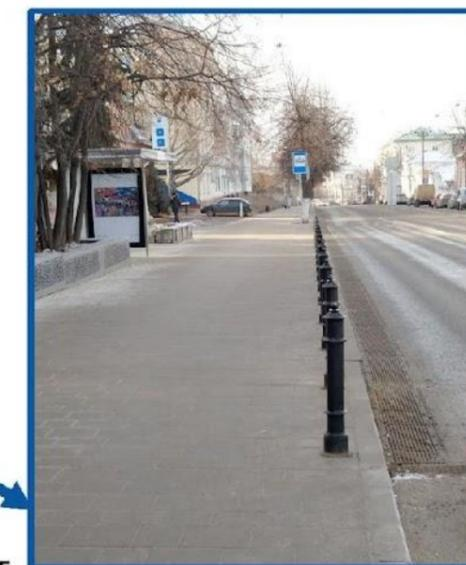
Выполнен ремонт улицы Спасская от ул. Ленина до ул. Дворцовая (в 2020 году был произведен ремонт **8960 кв.м.** межрельсового пространства с заменой **2745 кв.м.** тротуарной плитки);
