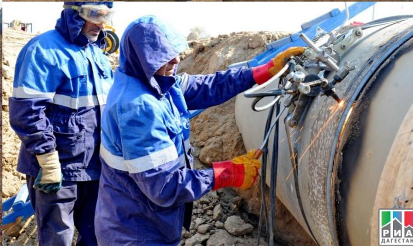
При повреждении, нанесенном криминальной врезкой запорному устройству или соединительному элементу трубопровода (тройнику, переходнику и т.п.), восстановление производится путем замены дефектной детали на новую.
