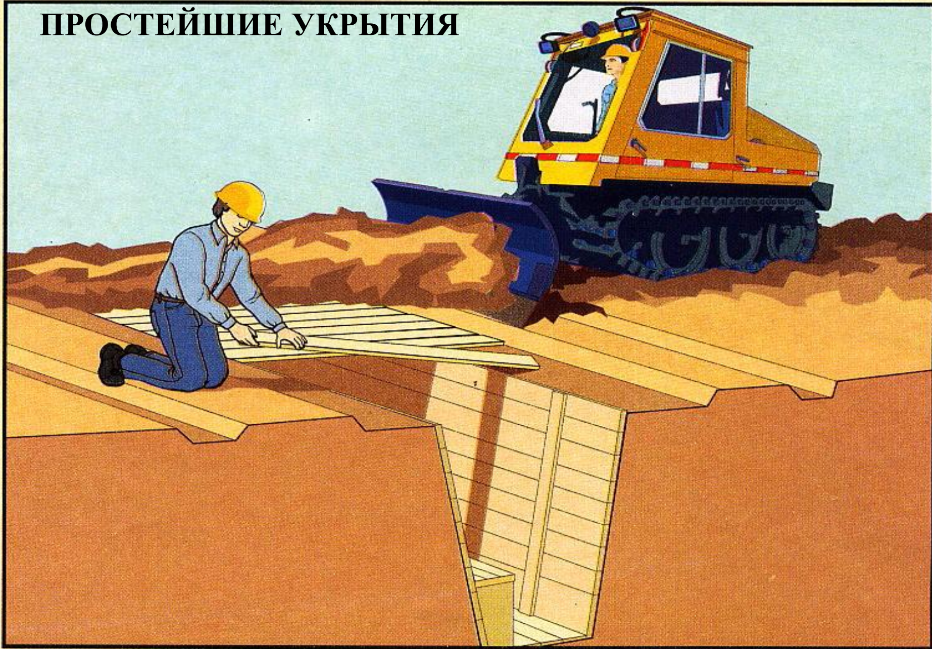
Оборудование перекрытой щели
