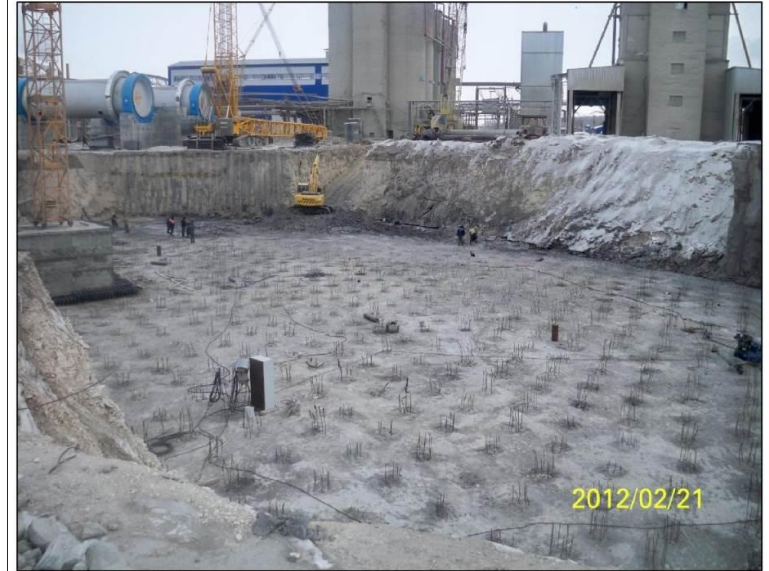
ВЫПОЛНЕННОЕ СВАЙНОЕ ПОЛЕ
