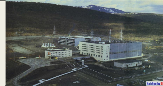
Билибинская АЭС на Чукотке
