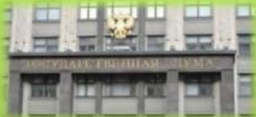
На зданиях госучреждений
