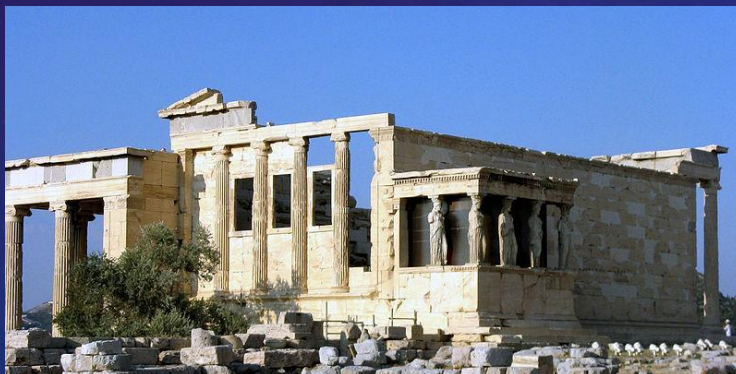
1. Вид Эрехтейона с северо-западной стороны.
