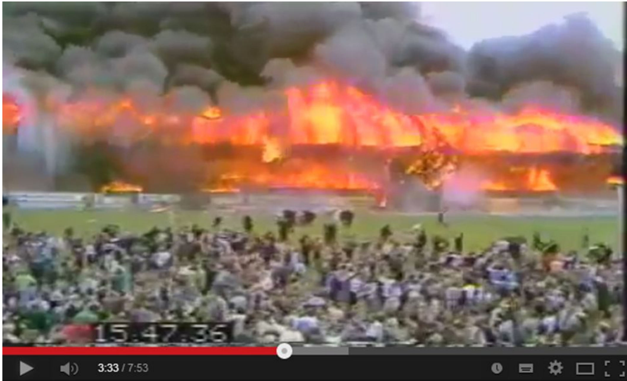
Пожар на стадионе Брэдфорда
