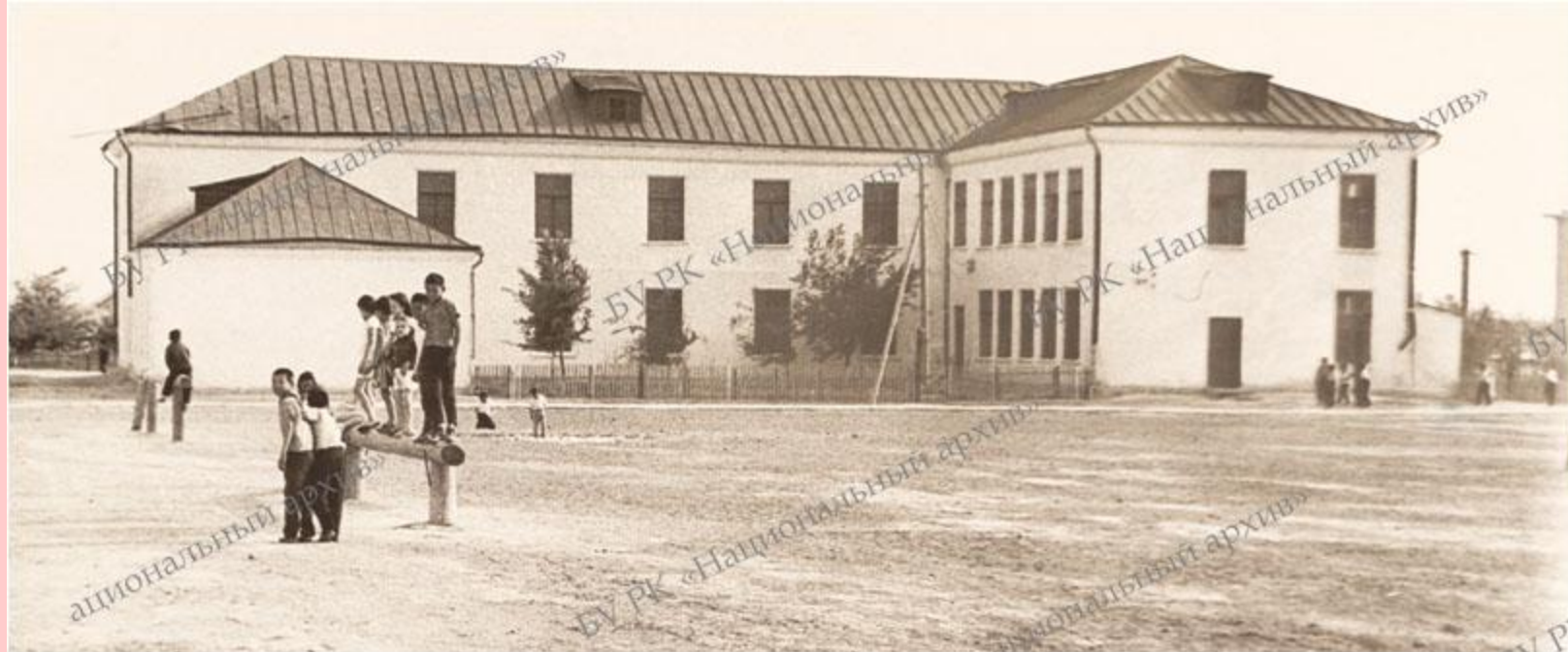
Здание средней школы племзавода "Черноземельский". 1975 г.
