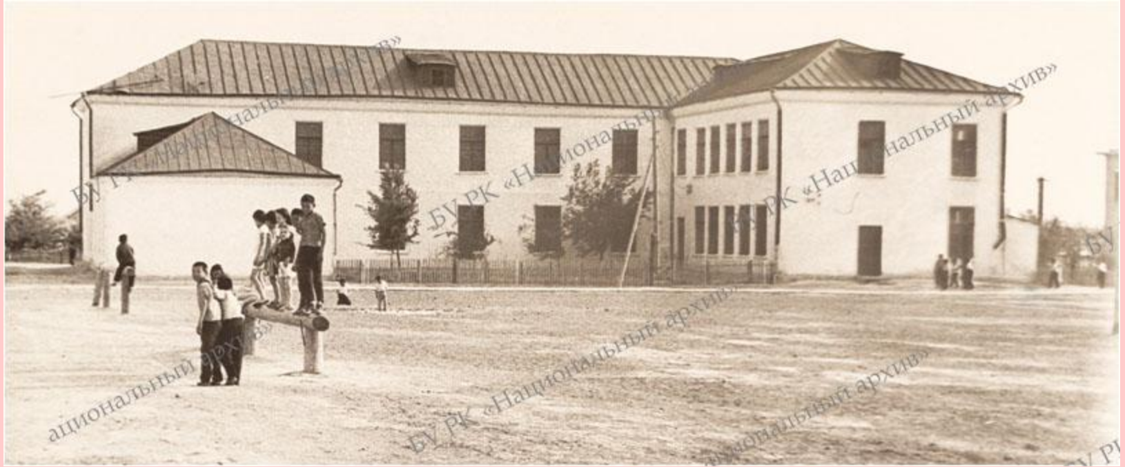
Здание средней школы племзавода "Черноземельский". 1975 г.
