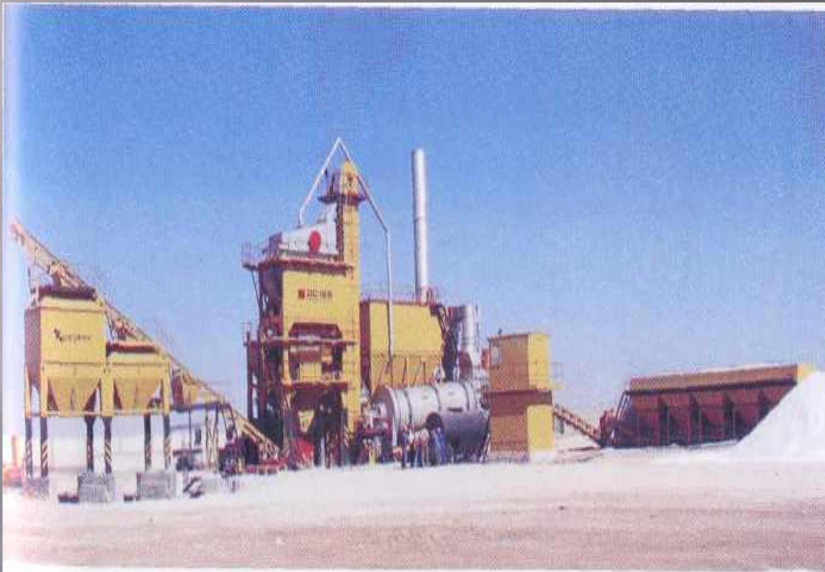
Асфальтосмесительная установка ДС-168
