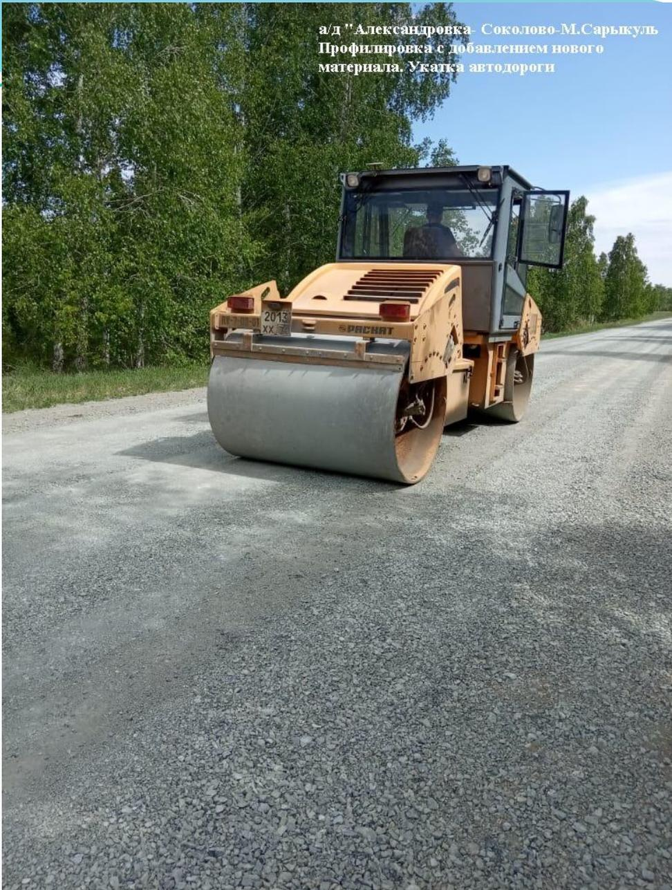
● Неоднократные обращения граждан по необходимости ликвидации гребенчатости и подсыпки материала с его последующей профилировкой и укаткой.
