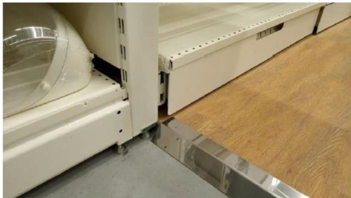
При нижней подводке электрики полы укладываем на два листа МДФ (2х1,6мм).
