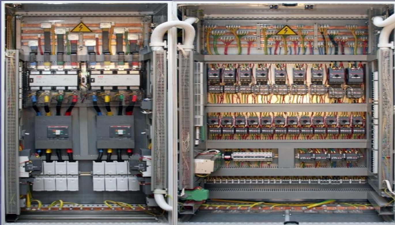
НКУ представляют собой совокупность низковольтных аппаратов, приборов и устройств, смонтированных на единой конструктивной основе со всеми внутренними электрическими и механическими соединениями и конструктивными элементами.
