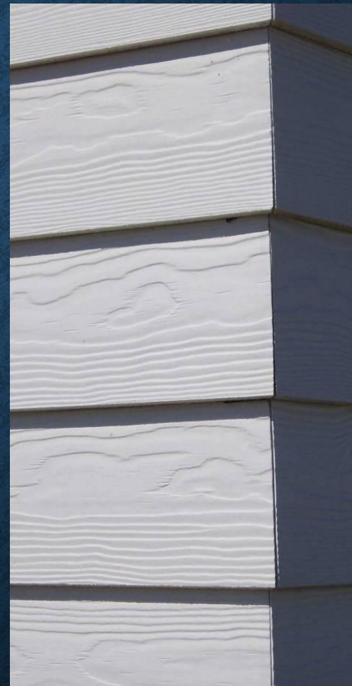
Фасадные панели с торцом под углом 45%
