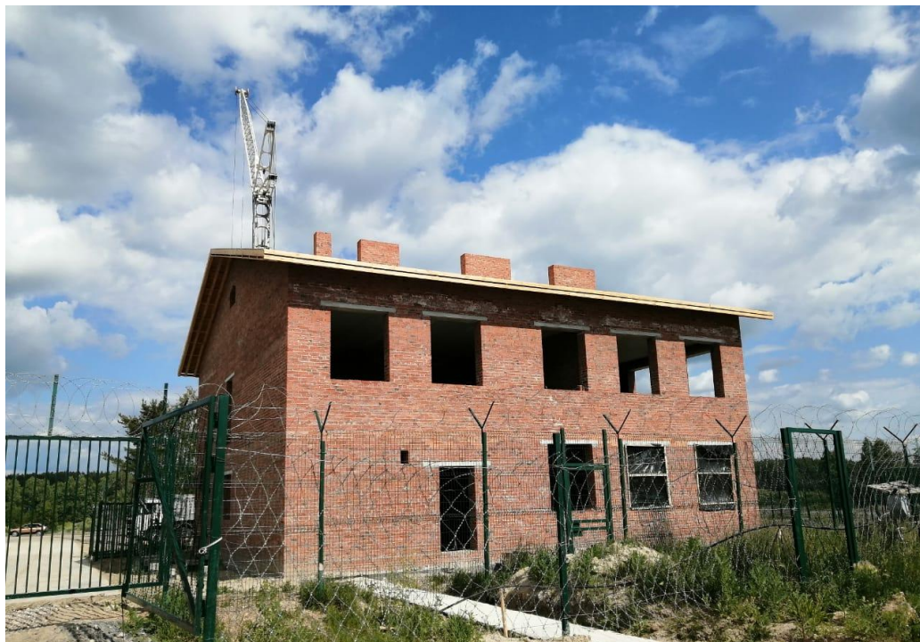
Контрольно-технический пункт (КТП)
