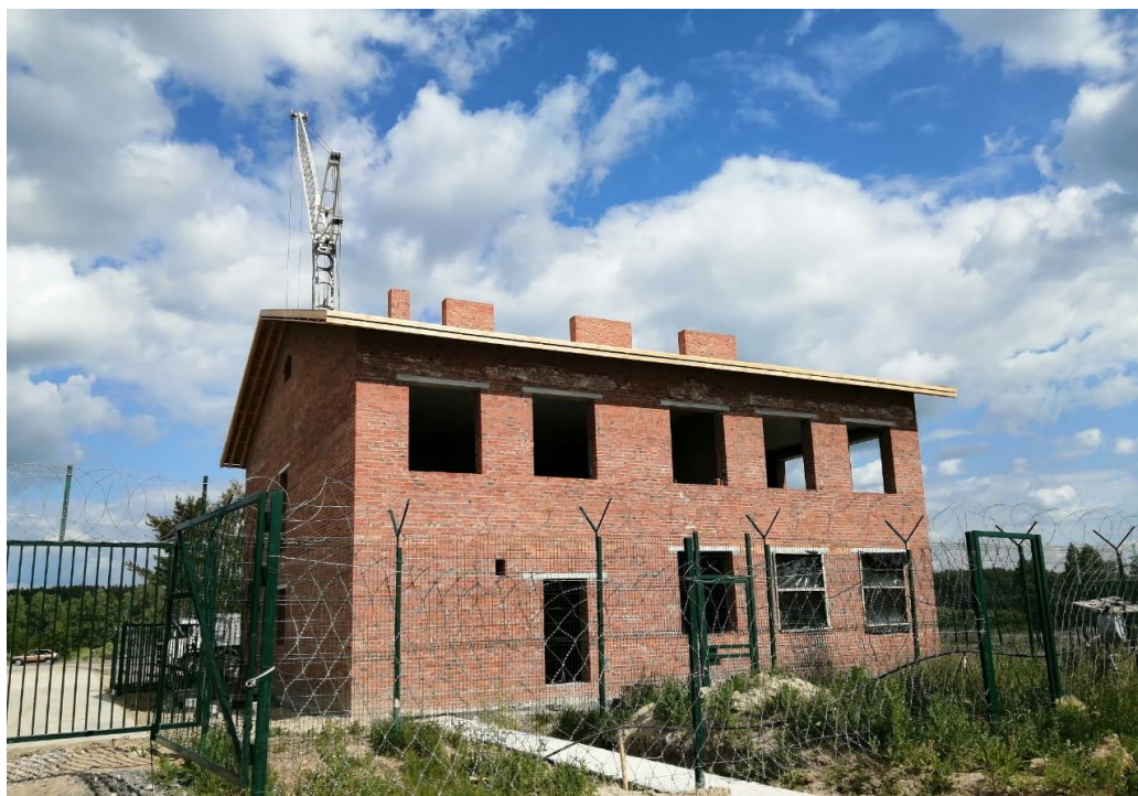
Контрольно-технический пункт (КТП)
