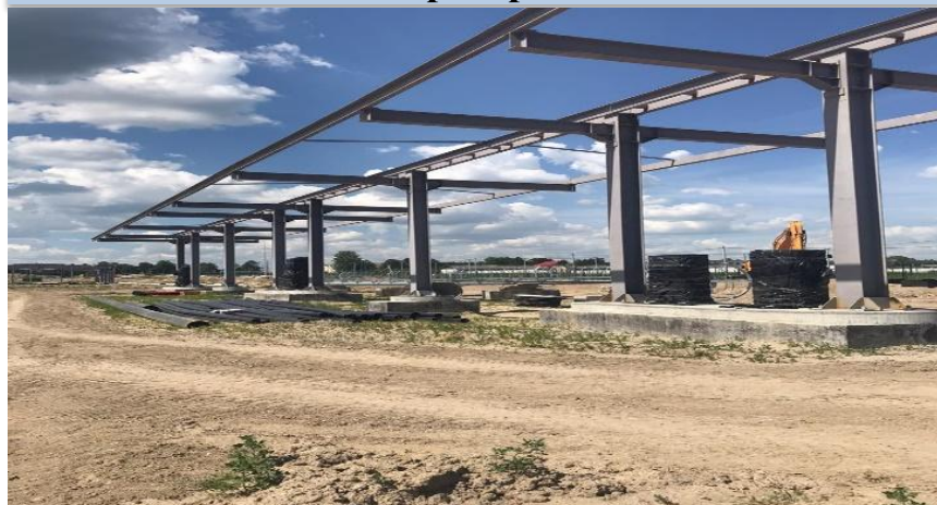
Навес с топливозаправочными колонками пункта заправки техники
