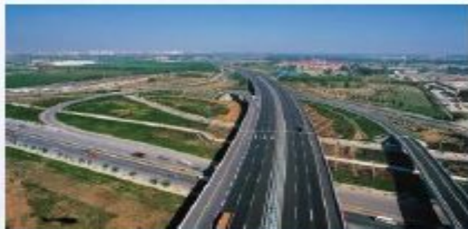
Автомобильные дороги Расширен состав работ
