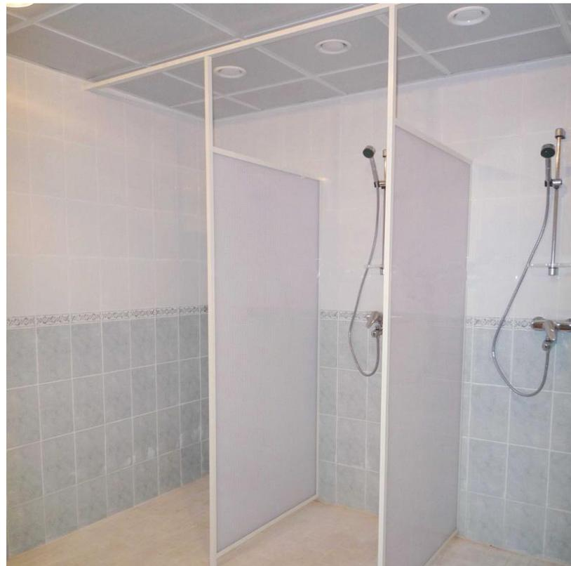
Оптимальный вариант материала перегородки – прозрачный или цветной поликарбонат толщиной 16 мм.
