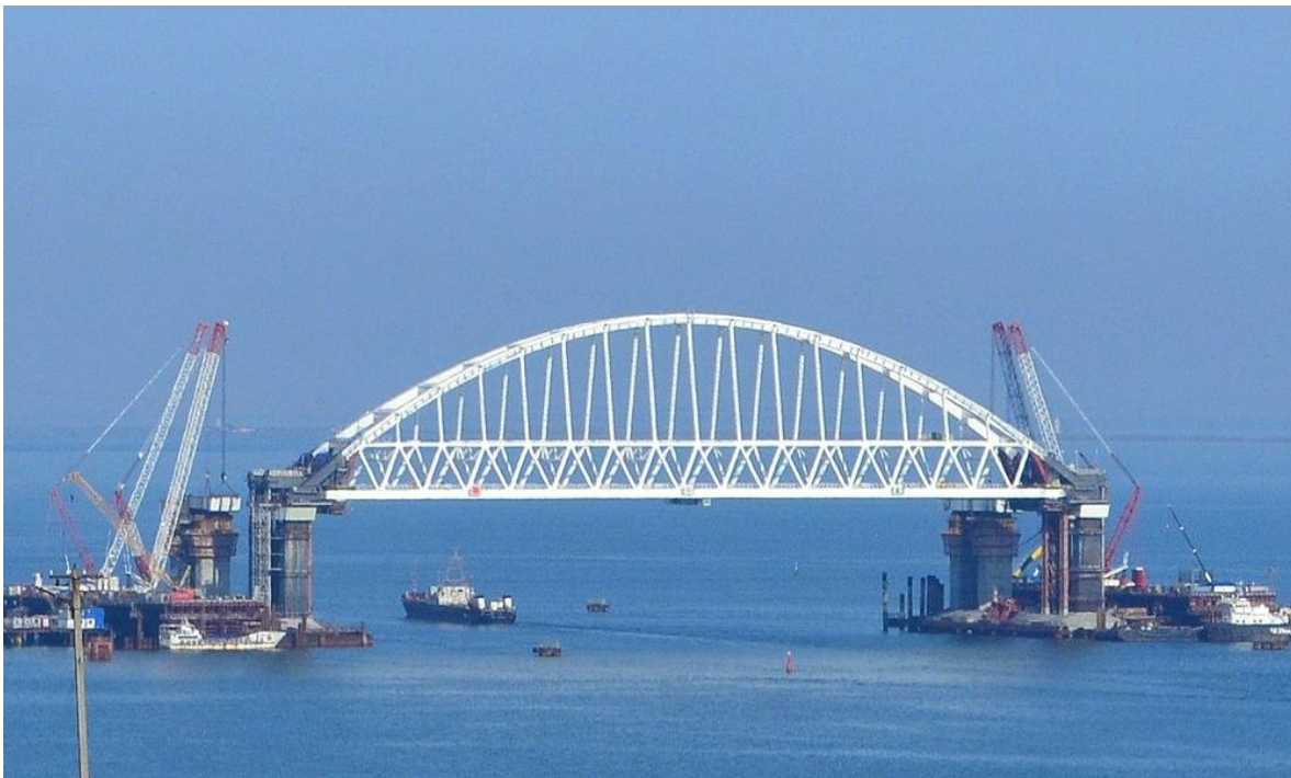
Установка арки Крымского моста
