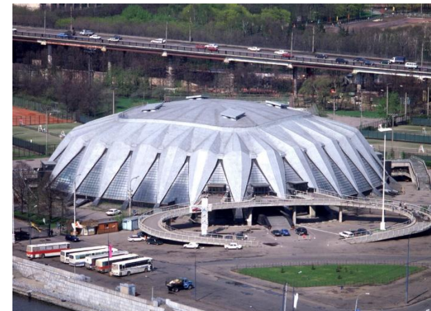
Складчатое покрытие спортивного зала «Дружба» в Москве
