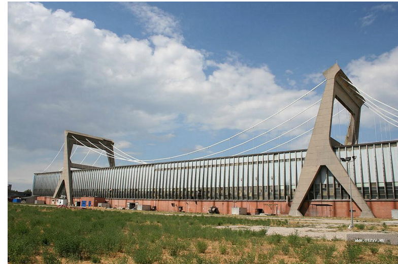
Висячая конструкция фабрики в Мантуе
