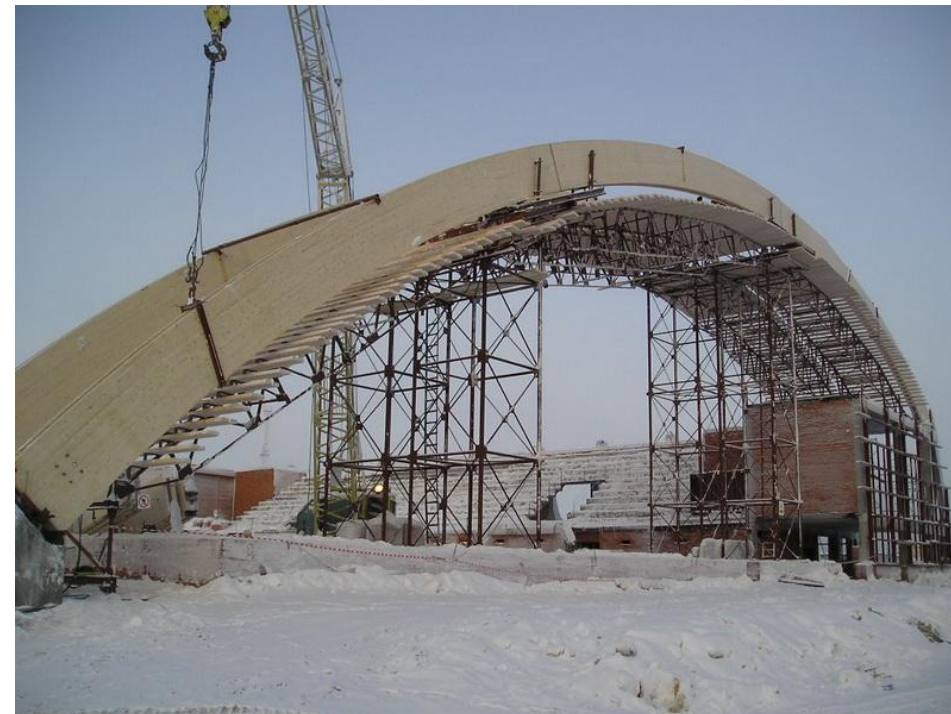
Клеедеревянные арки покрытия спортивного сооружения
