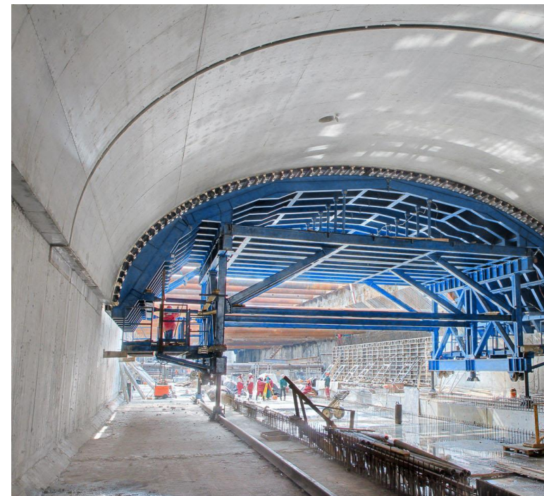
Свод строящейся станции метрополитена в Москве
