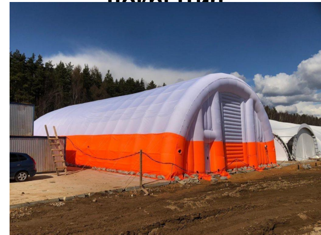
Пневнокаркасный (воздуходнесомый) ангар
