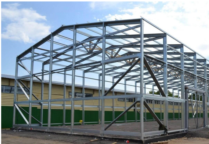
Стойчно-балочная система из легких металлических конструкций
