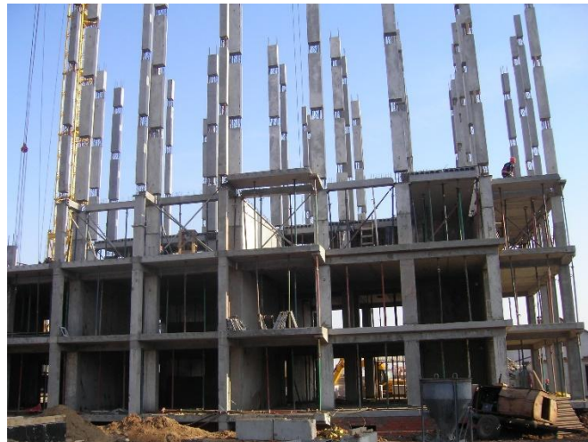
Сборно-монолитный железобетонный каркас (стойчно-балочная система)
