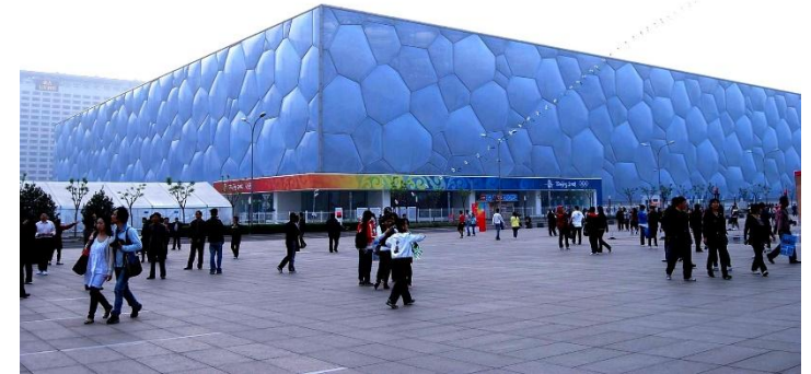
Стадион водных видов спорта в Пекине с воздухоопорными элементами ограждающего покрытия
