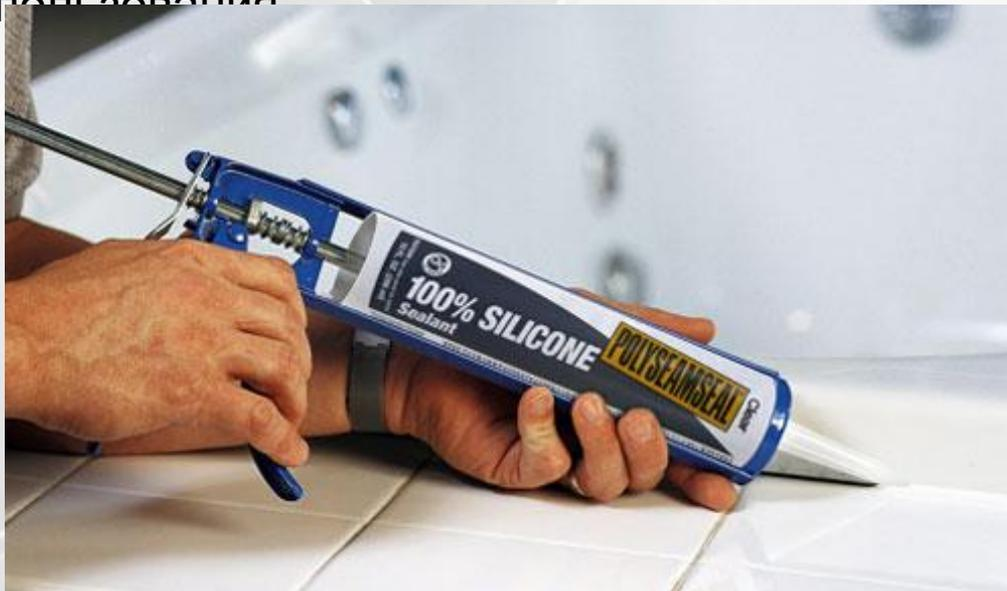
Жидкие кремнийорганические каучуки применяют в виде герметиков, компаундов, антикоррозионных покрытий и других материалов
