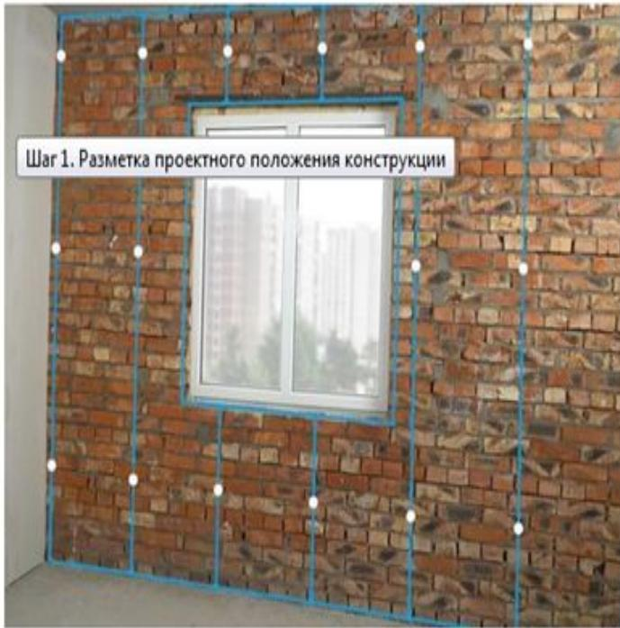
Шаг 1. Разметка проектного положения конструкции
