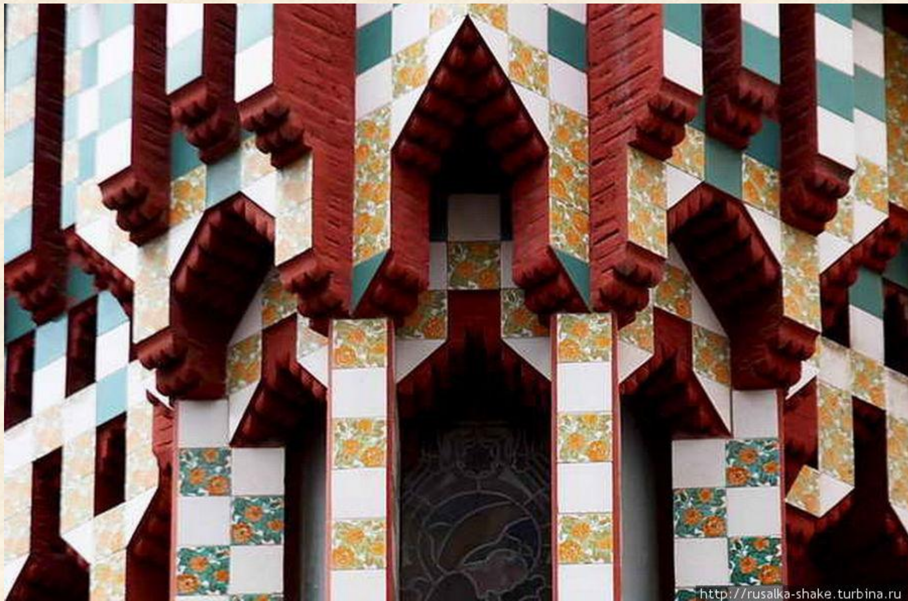
Отделка керамической плиткой.
