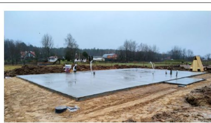
Фото №5 фундамент с коммуникациями
