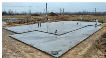
Фото №7 фундамент с коммуникациями
