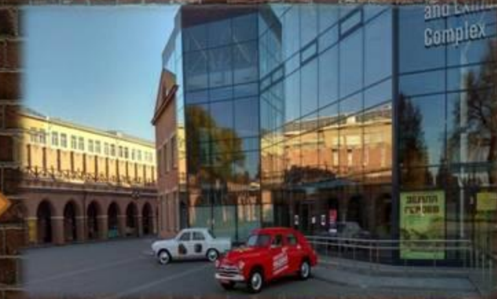
Здание городской электростанции (1900)
