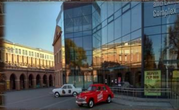
Здание городской электростанции (1900)
