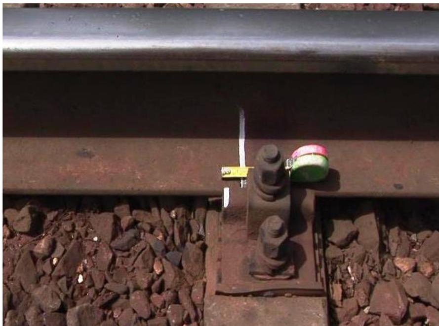
3. Укорочение плети **на 10мм и более, но не свыше 20мм (смещение рисков внутрь контрольного участка)** и ожидаемом повышении температуры рельсов относительно температуры закрепления более чем на  $15^{\circ}\text{C}$ , то на период действия указанных температур до выполнения регулировки напряжений ограничивают скорость до 60 км/ч
