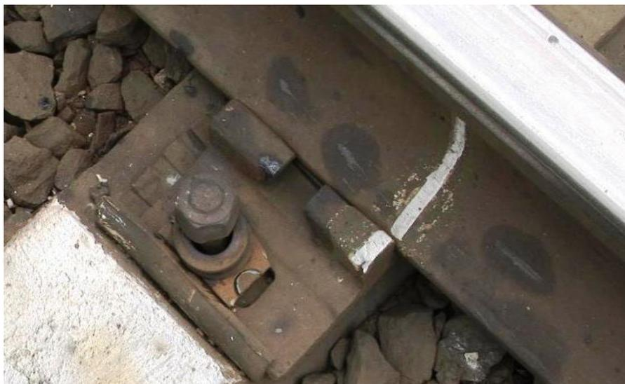
1. При смещении контрольных сечений относительно «маячных» шпал **до 5мм включительно** – проверяют состояние скреплений, заменяют дефектные элементы, подтягивают гайки болтов, шурупы, при скреплении АРС-4 монорегулятор устанавливают на четвёртую позицию
