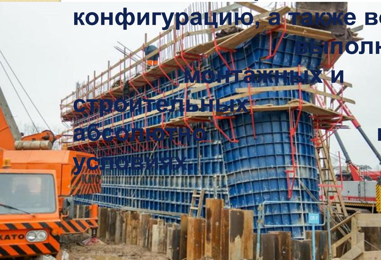
система. Может использоваться для создания как линейных сооружений, так и криволинейных, и конусовидных. Она состоит из типовых элементов, которые можно настраивать. К ее достоинствам относят высокую несущую способность и демократичную цену.
