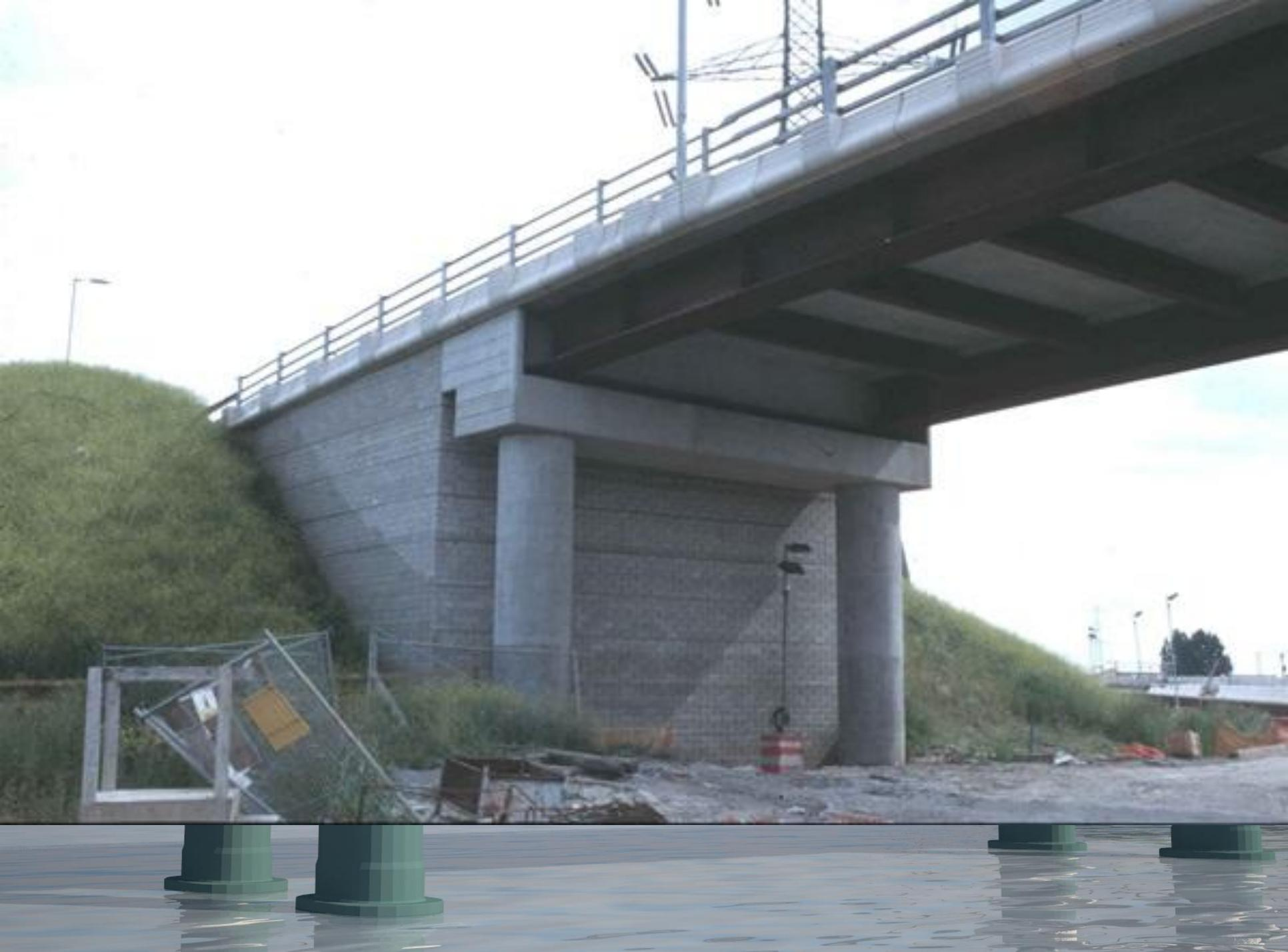
**Опора моста состоит из фундамента, оголовка и тела опоры.**
