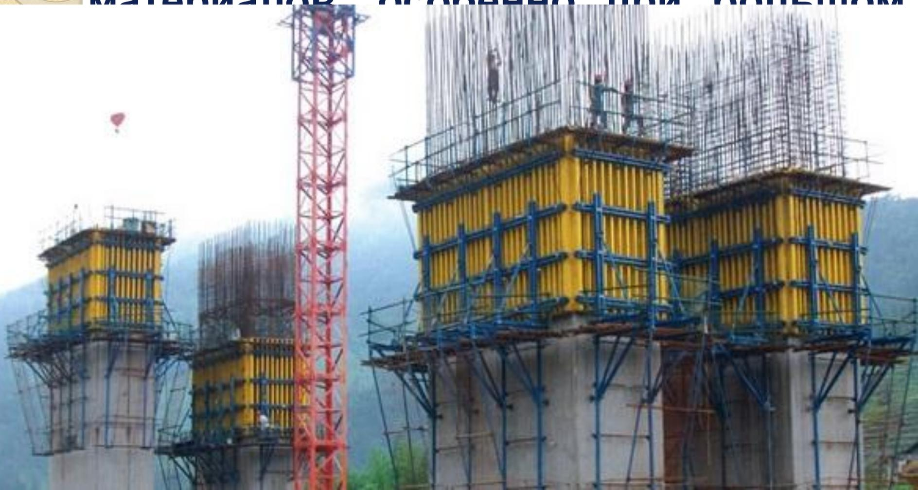
Речные и береговые опоры больших мостов возводят из монолитного бетона в стационарной или в щитовой сборной деревянной опалубке.
