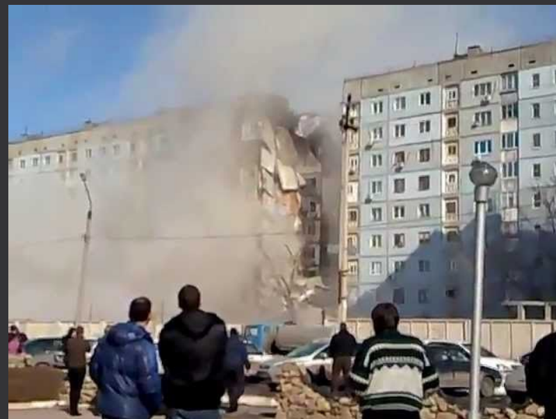
Обрушение здания в Астрахани
