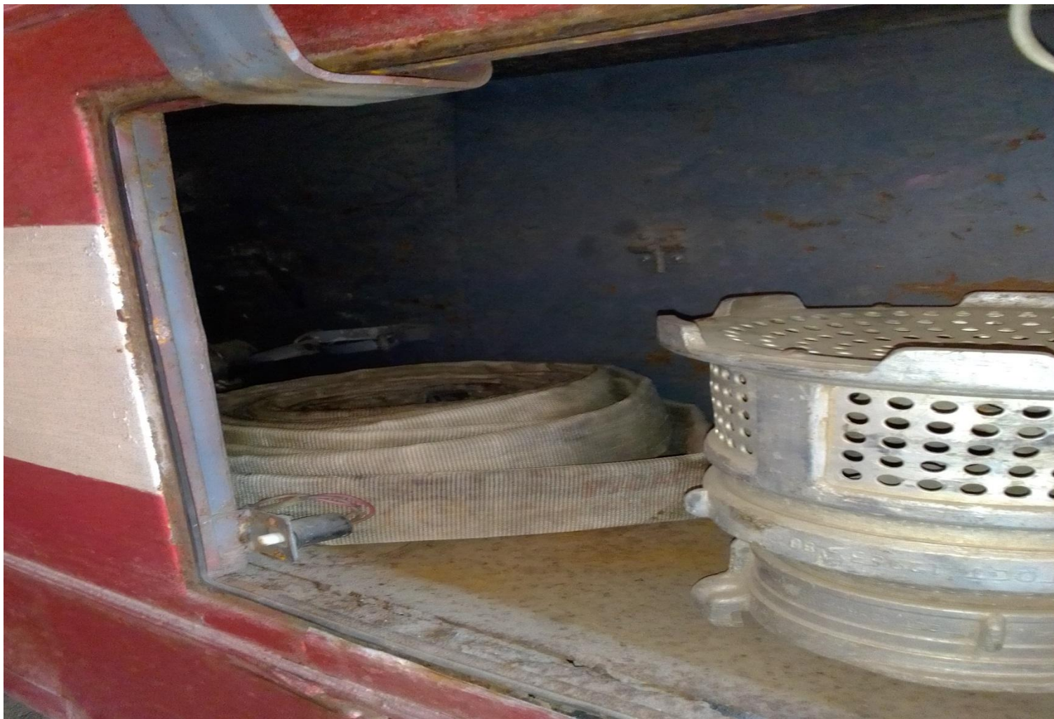
Рис. 8 Место для хранения пожарно-технического оборудования
