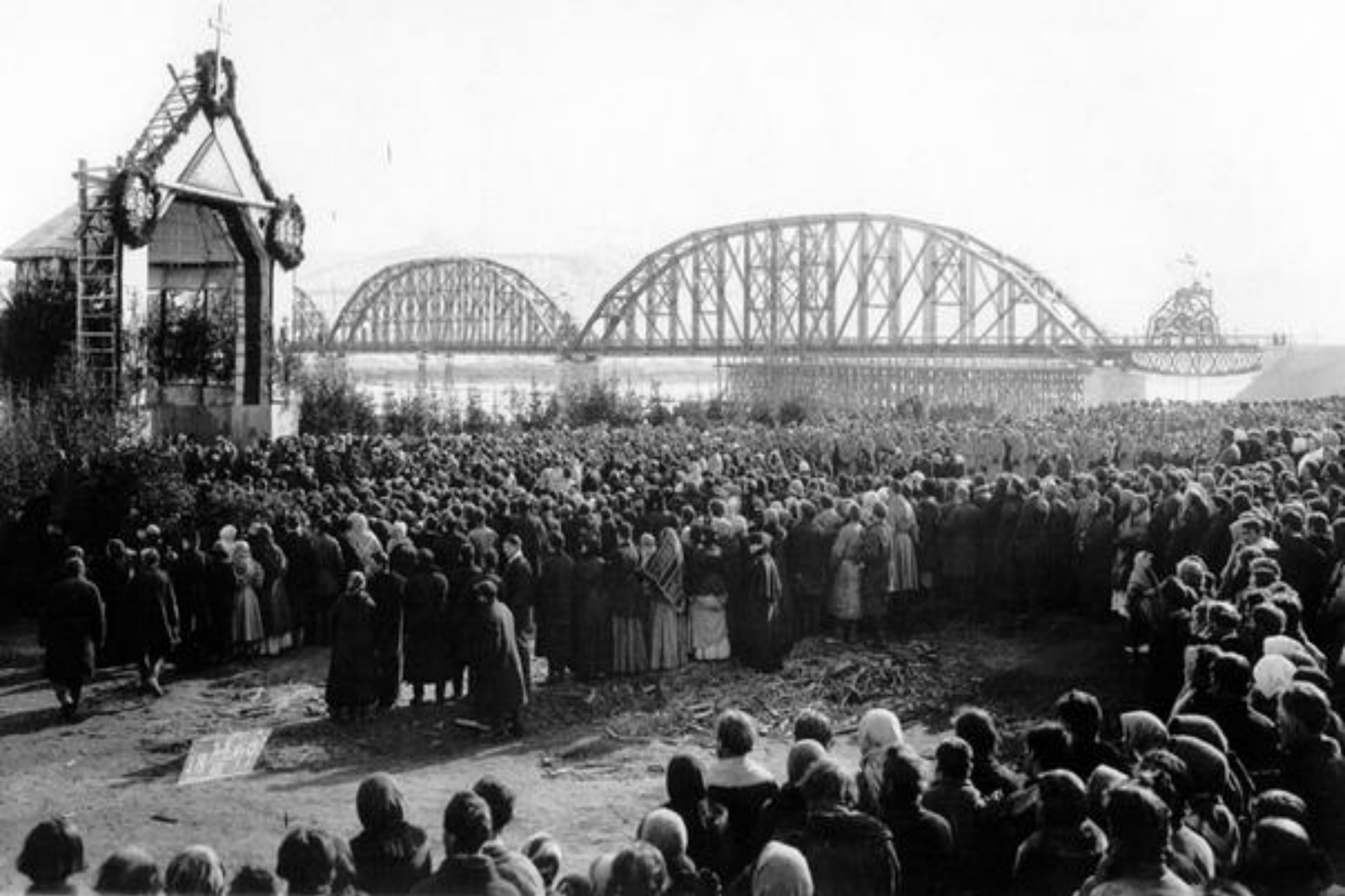
Автомобильный мост через р.Кача (Открытие железнодорожного моста 1899 г.)
