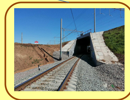
Строительство путепроводной развязки на станции Гумрак
