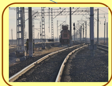
Реконструкция станций Тингута, Канальная, Горнополянский
