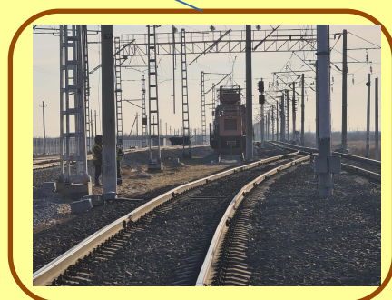
Реконструкция станций Тингута, Канальная, Горнополянский
