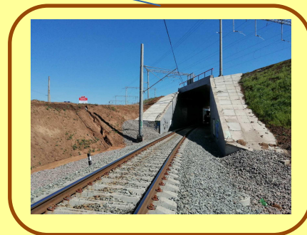
Строительство путепроводной развязки на станции Гумрак
