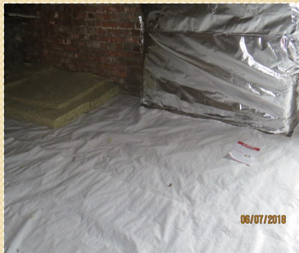
Теплоизоляция перекрытий чердачных помещений
