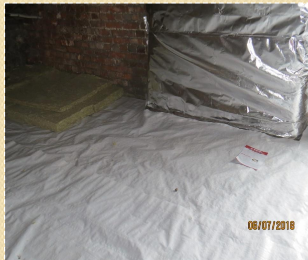
Теплоизоляция перекрытий чердачных помещений
