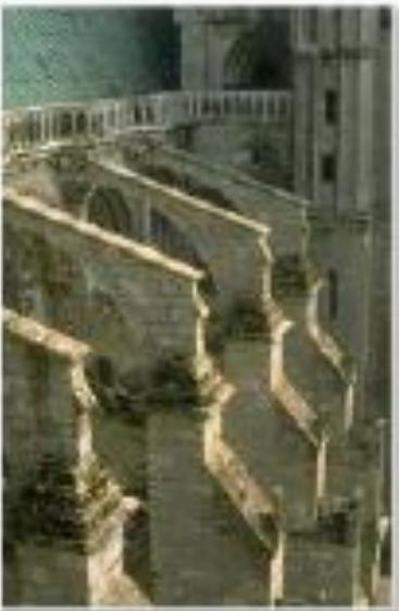
*Внешние стены здания окружили мощные контрфорсы, на которые перенесли тяжесть сводов боковых нефов.*
