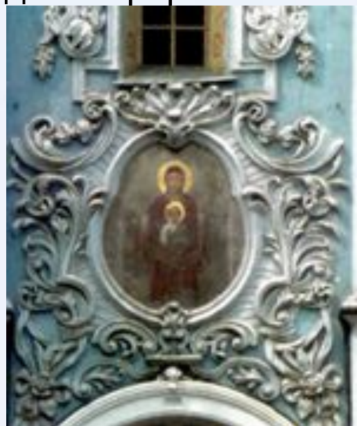
Фрагмент східного фасаду
