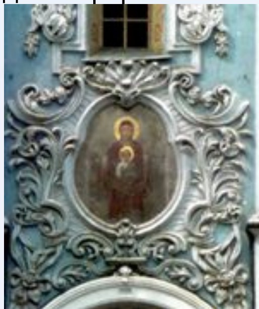
Фрагмент східного фасаду
