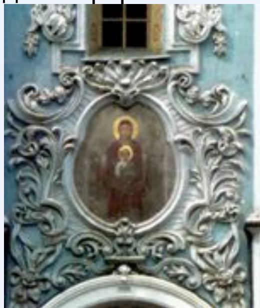
Фрагмент східного фасаду
