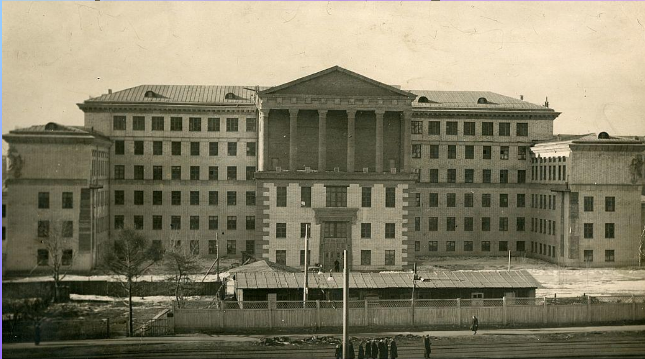
Строительство здания Московского высшего художественно-промышленного училища (б.Строгановское). 1956-1958 гг.
