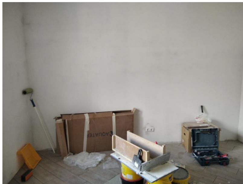
Жилая комната №1 – северная стена
