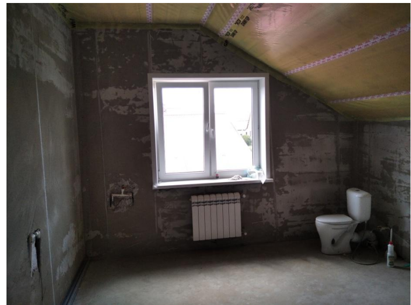
Санузел 2 этажа – южная стена
