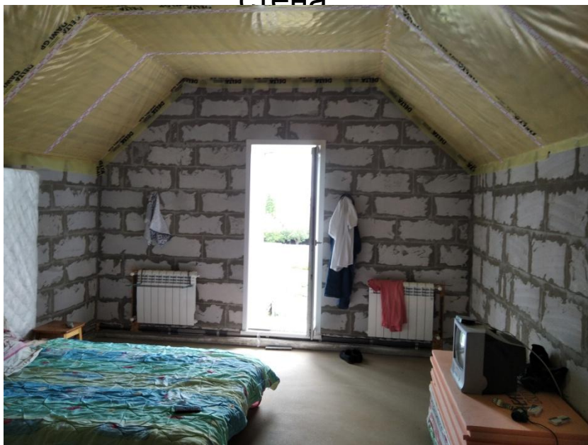
Жилая комната №4 – восточная стена
