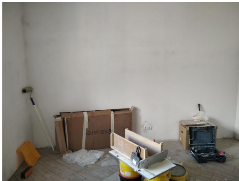
Жилая комната №1 – северная стена
