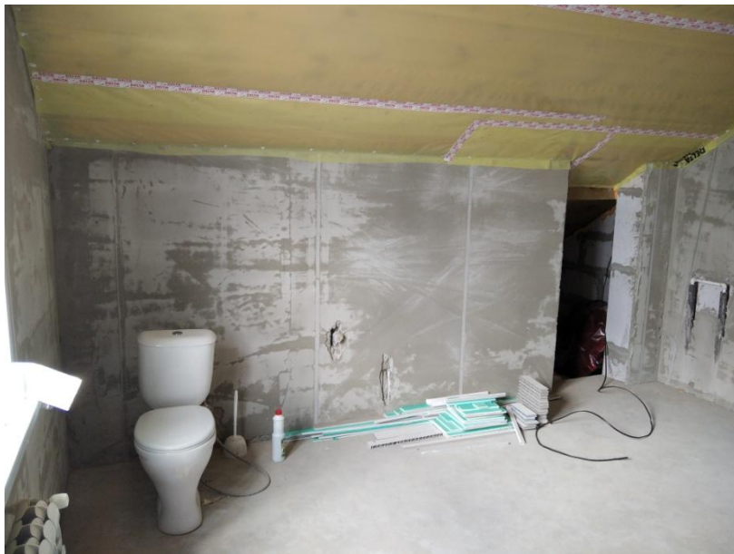
Санузел 2 этажа – западная стена
