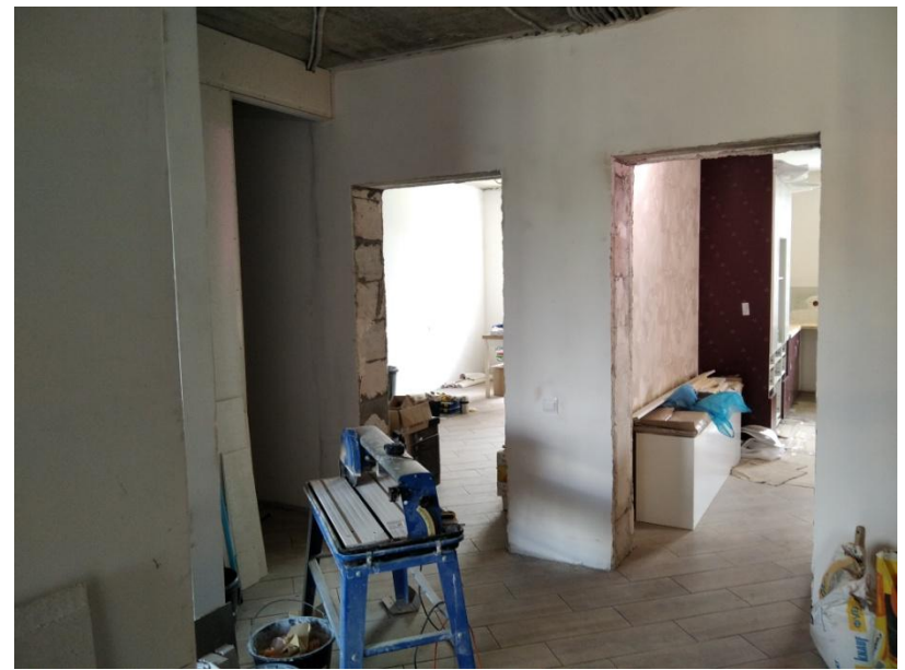
Коридор – вид слева от входа
