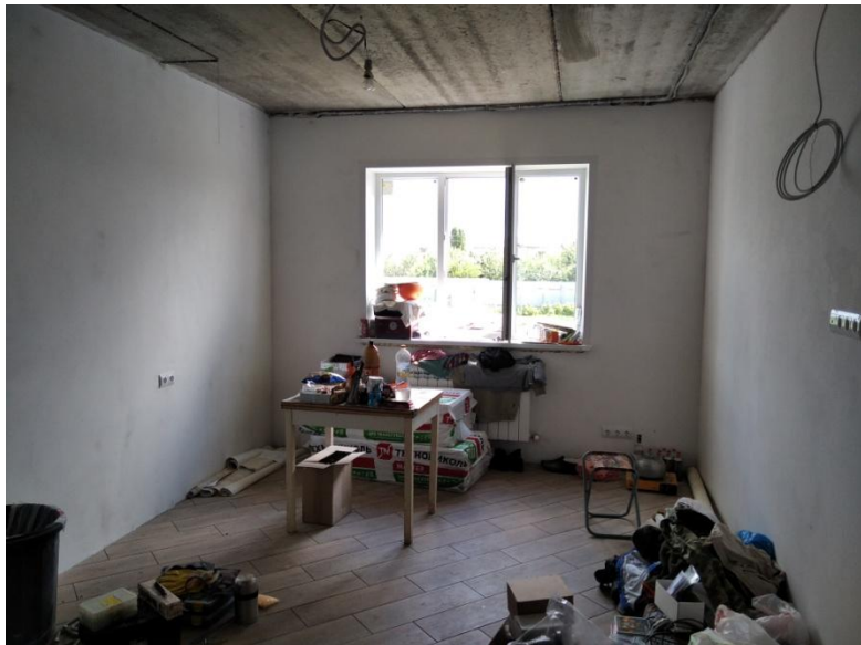
Жилая комната №2 – восточная стена
