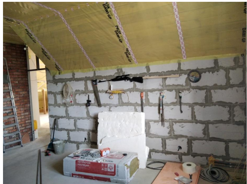
Жилая комната №5 – южная стена
