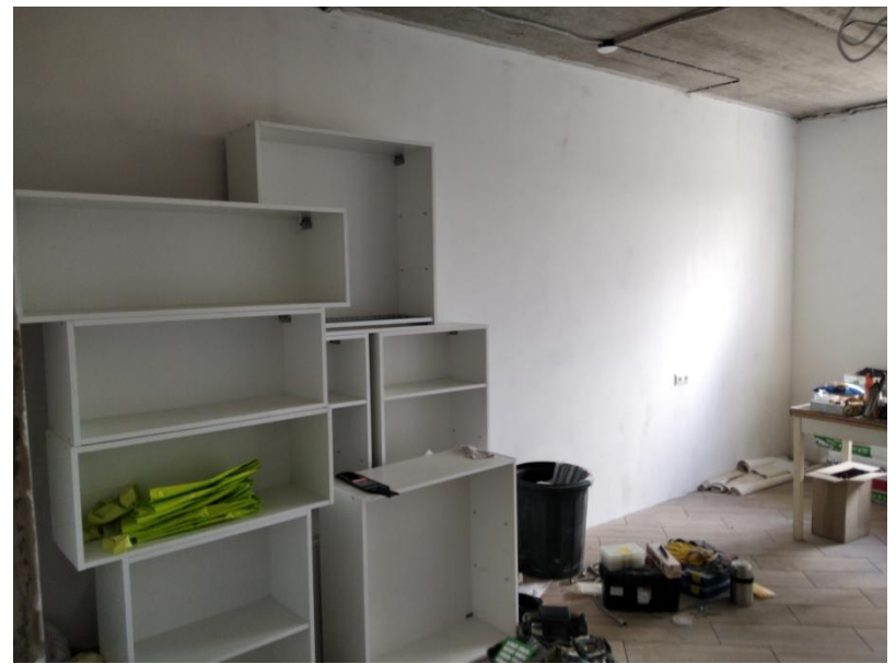
Жилая комната №2 – северная стена
