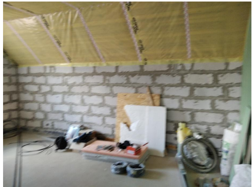
Жилая комната №5 – северная стена
