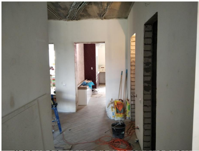
Коридор – вид прямо от входной двери
