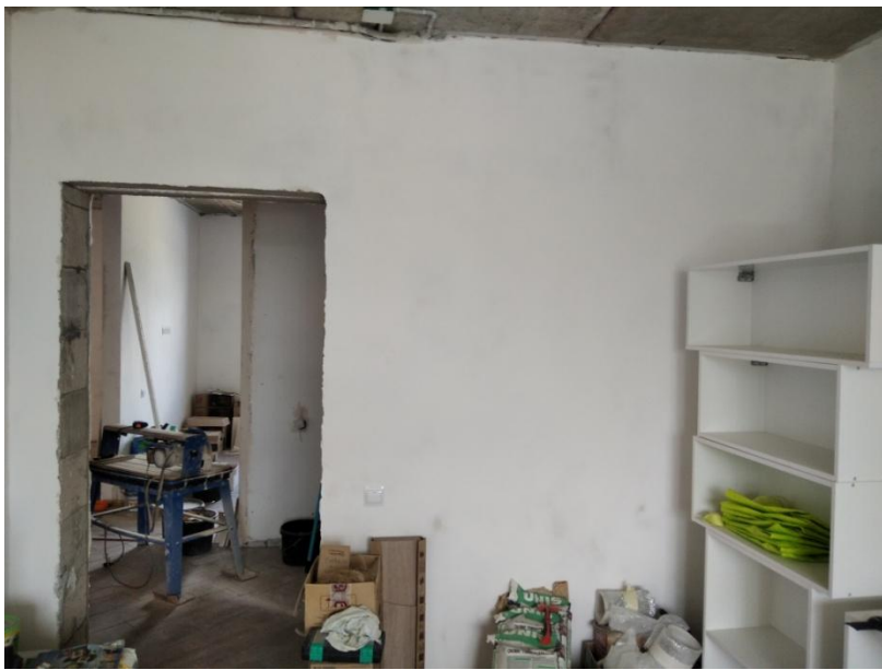
Жилая комната №2 – западная стена
