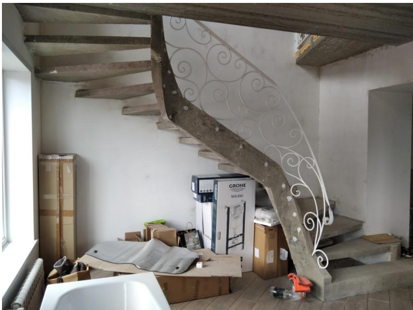
Столовая – западная стена
