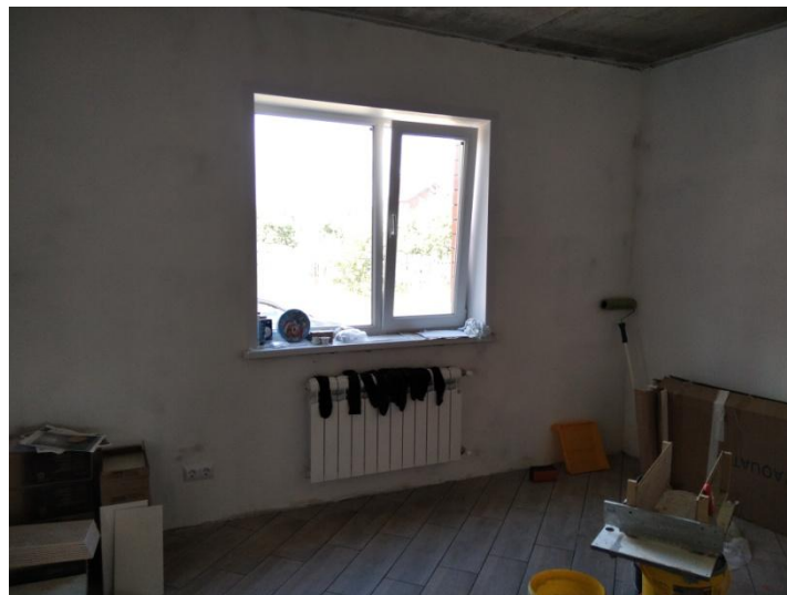
Жилая комната №1 – западная стена
