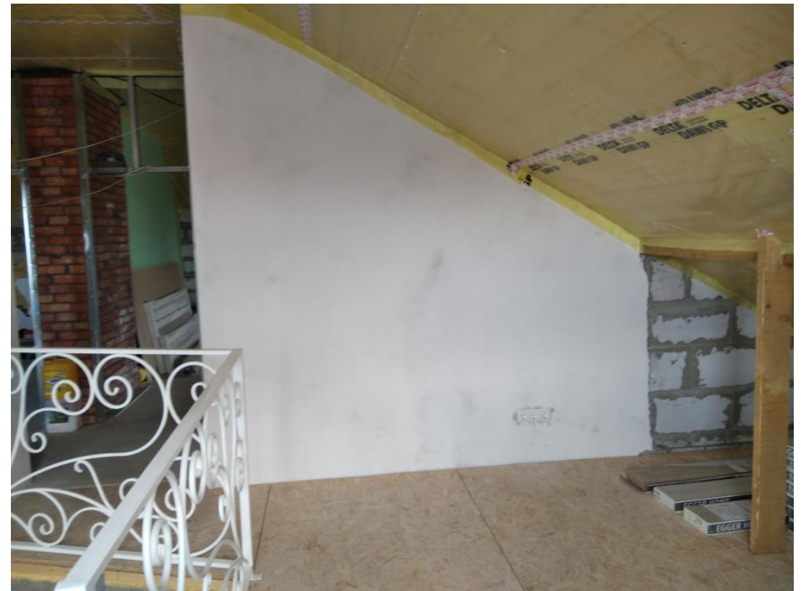
Жилая комната №3 – северная стена
