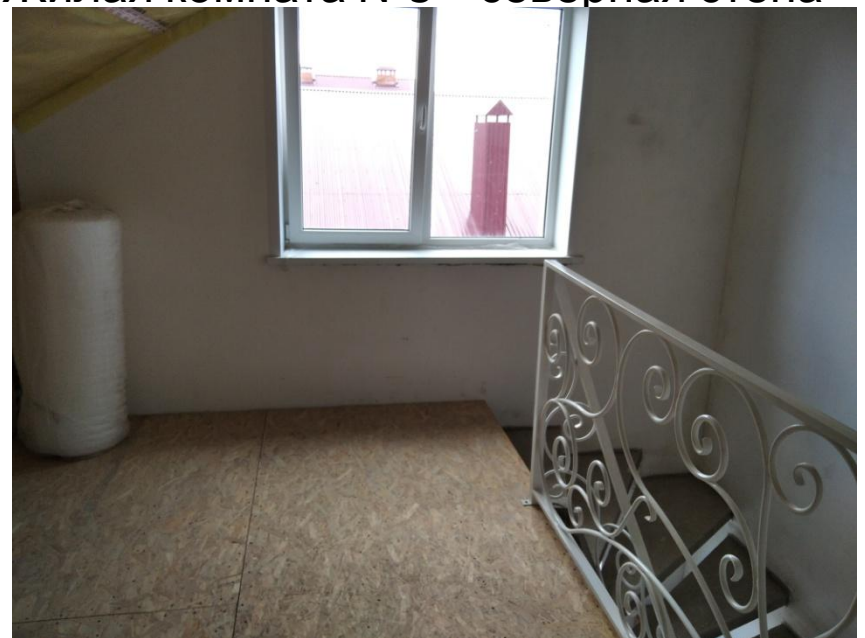
Жилая комната №3 – южная стена
