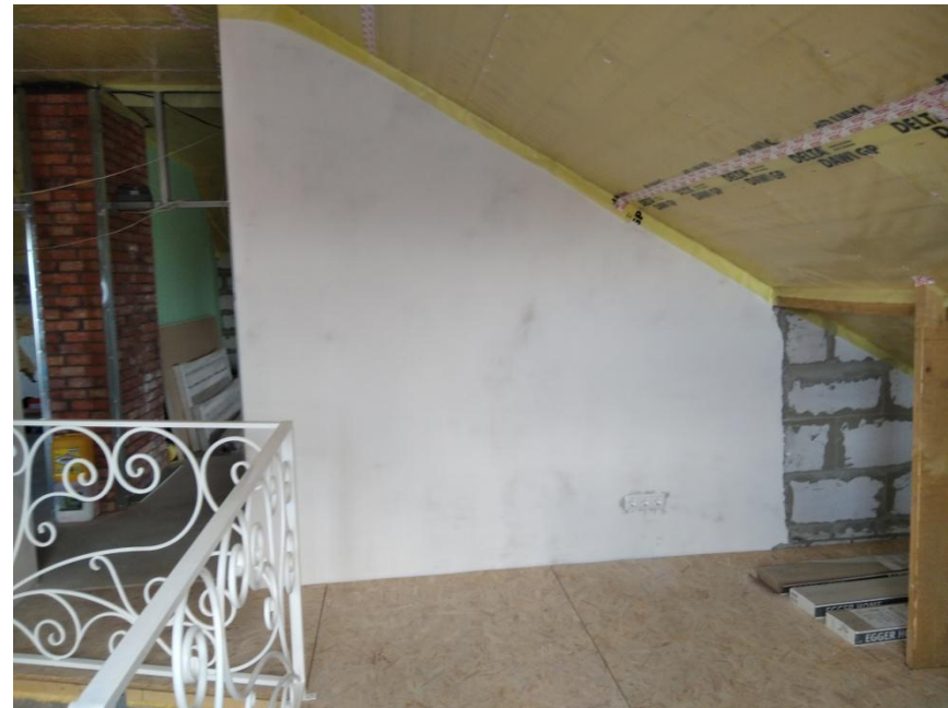
Жилая комната №3 – северная стена
