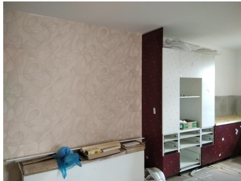
Кухня – северная стена
