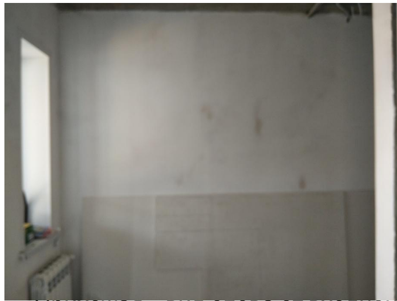
Прихожая – вид слева от входной двери
