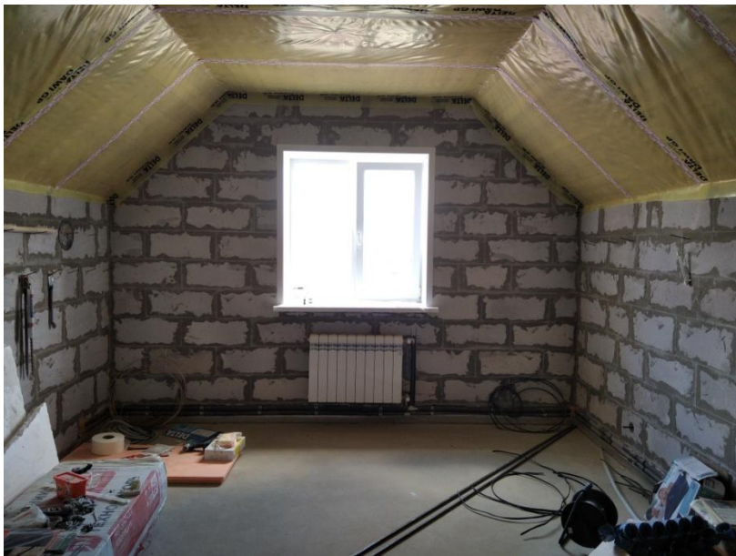
Жилая комната №5 – западная стена
