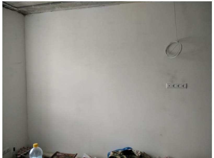
Жилая комната №2 – южная стена
