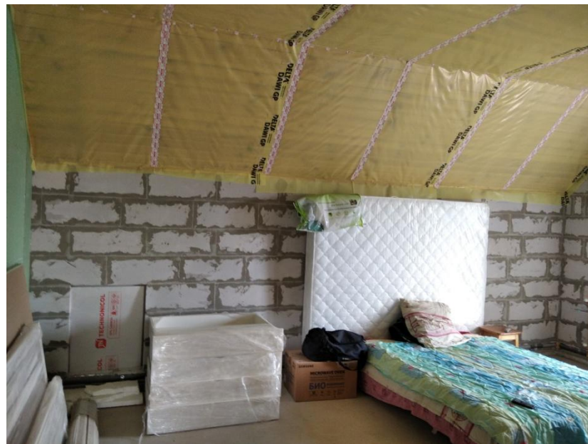
Жилая комната №4 – северная стена
