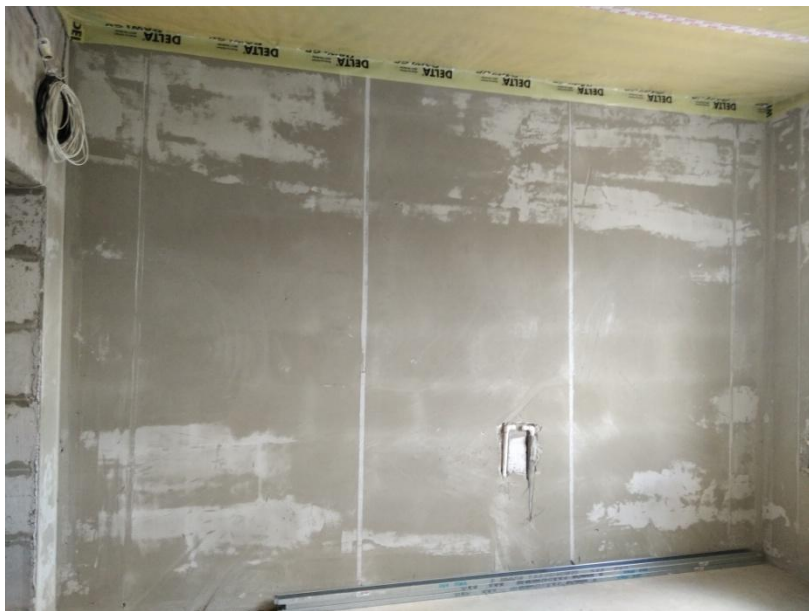
Санузел 2 этажа – восточная стена
