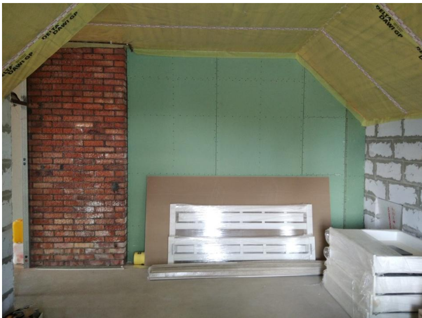
Жилая комната №4 – западная стена
