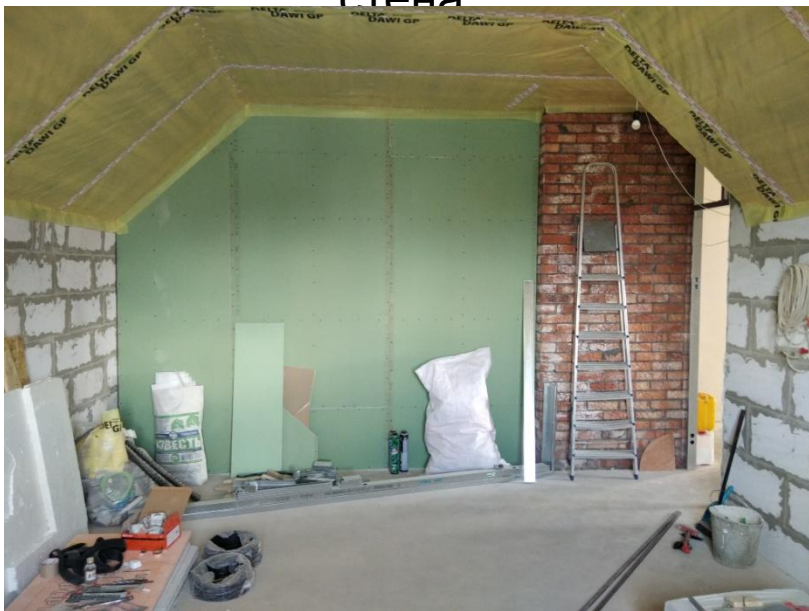
Жилая комната №5 – восточная стена
