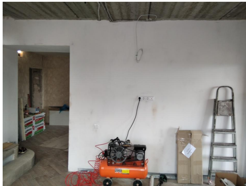
Столовая – северная стена
