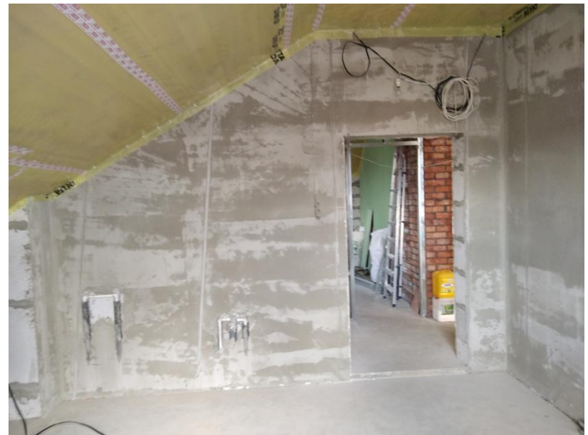
Санузел 2 этажа – северная стена
