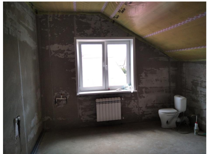
Санузел 2 этажа – южная стена
