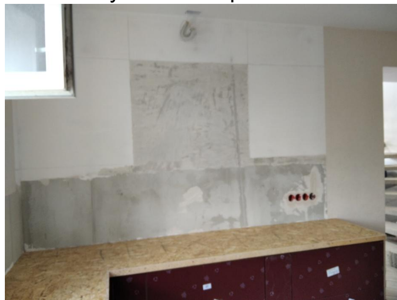
Кухня – южная стена
