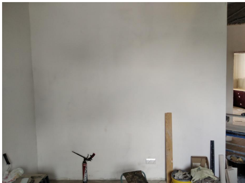
Жилая комната №1 – восточная стена
