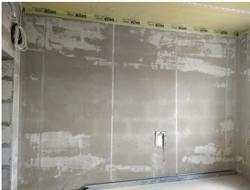
Санузел 2 этажа – восточная стена
