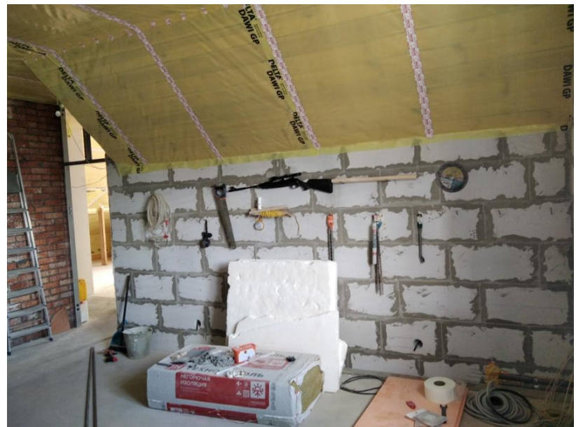
Жилая комната №5 – южная стена
