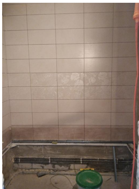
Ванная – вид от входа
