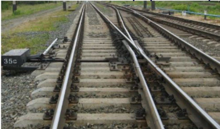
Стрелочный перевод с подвижным сердечником крестовины
