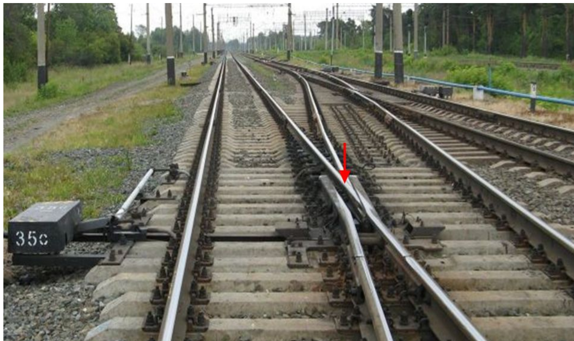
Стрелочный перевод с подвижным сердечником крестовины
