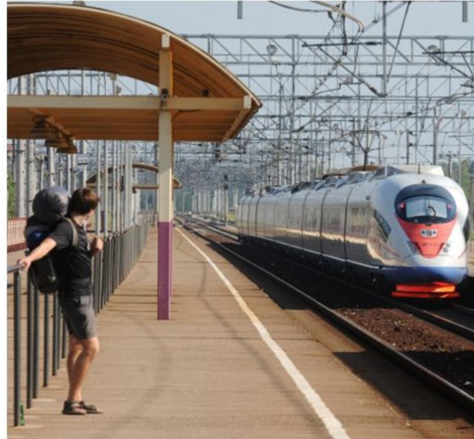
Пассажирские платформы, со скоростью движения более 200 км/ч, должны иметь предохранительные ограждения на расстоянии не менее 2 м от края платформы (п.53 ПТЭ)
