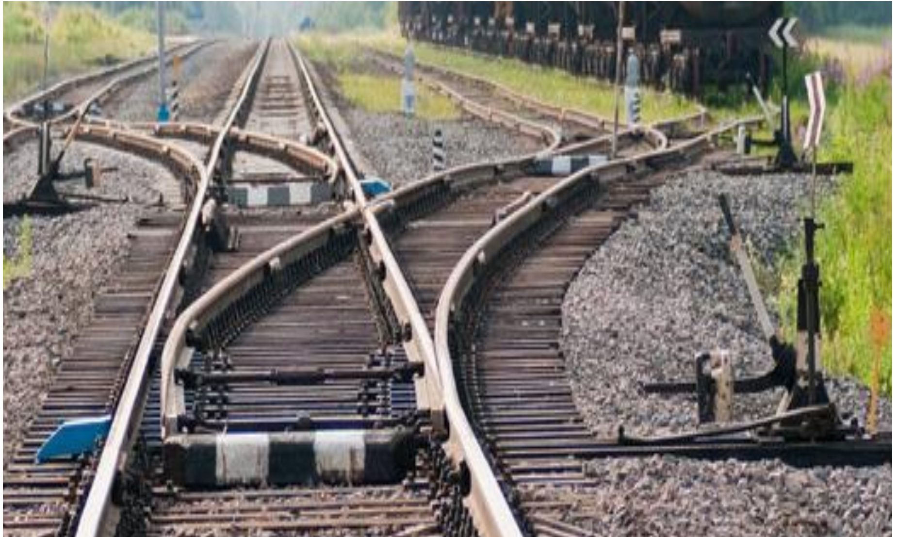
Нецентрализованный стрелочный перевод
