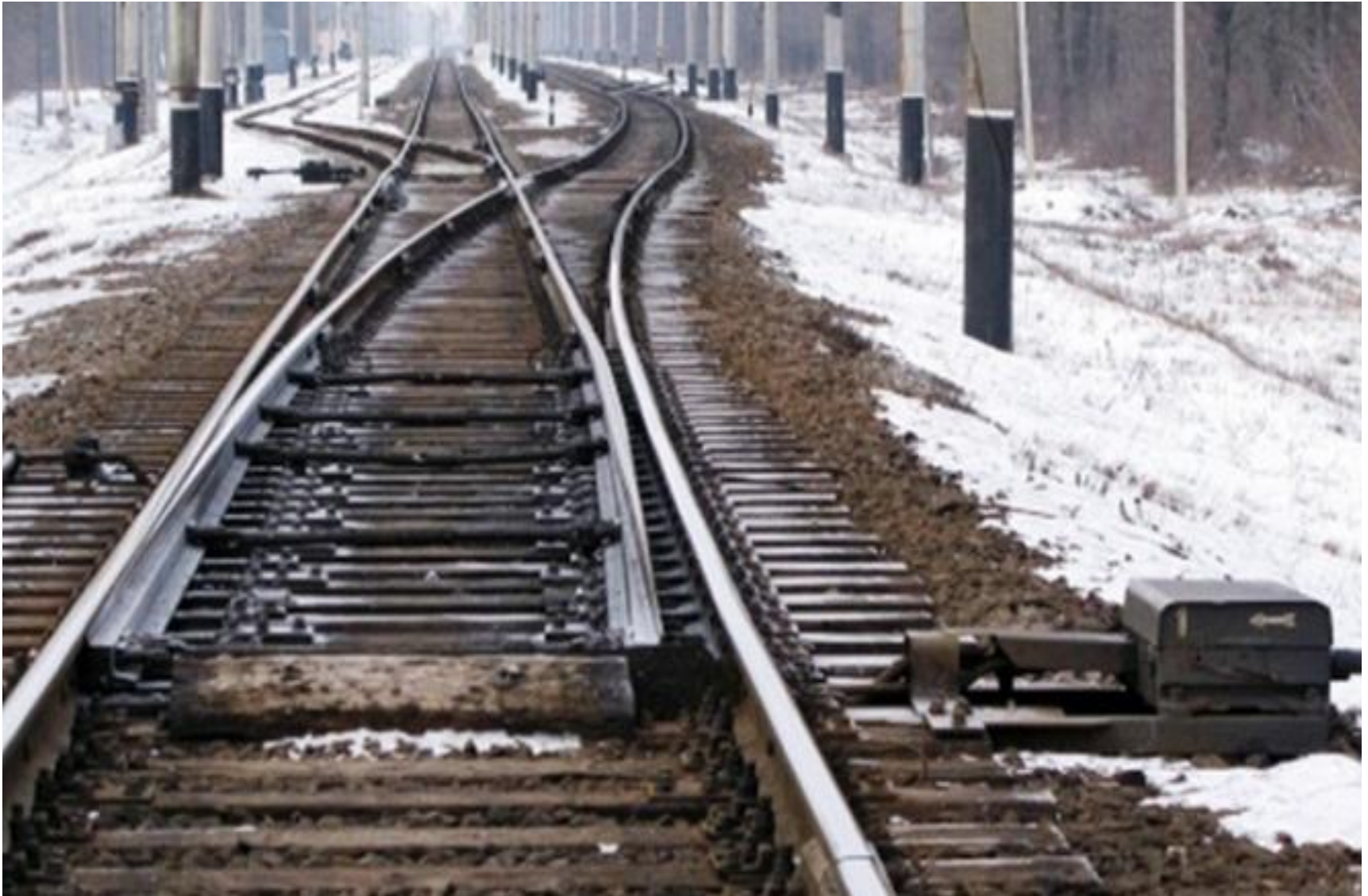
Централизованный стрелочный перевод
