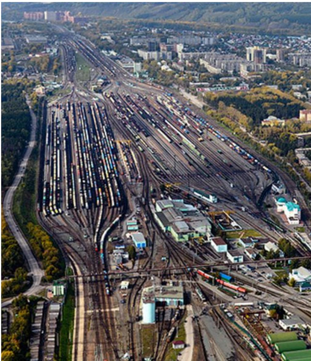
Станции, разъезды и обгонные пункты, а также отдельные парки и вытяжные пути должны располагаться на прямых участках. В трудных условиях допускается размещение их на кривых радиусом - не менее 1500 м. В особо трудных условиях допускается уменьшение радиуса кривой до 600 м, а в горных условиях - до 500 м
