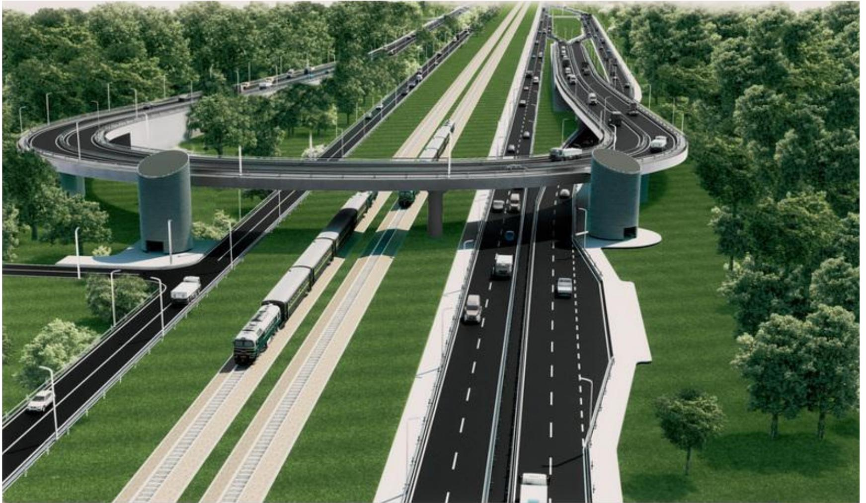
По участкам со скоростями движения более 200 км/ч, пересечения в одном уровне с автомобильными дорогами, трамвайными и троллейбусными линиями, не допускается (п.55 ПТЭ)
