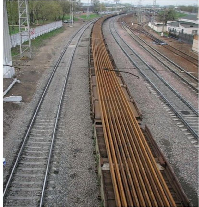
На всем протяжении железнодорожной линии, на которой осуществляется движение пассажирских поездов со скоростями более 140 км/ч, должен быть уложен бесстыковой железнодорожный путь - железнодорожный путь со сварными рельсовыми плетями, у которых при изменениях температуры воздуха концевые участки удлиняются или укорачиваются, а средняя часть остается неподвижной и в ней возникают продольные силы, пропорциональные изменениям температуры воздуха. (п.51 ПТЭ) ь
