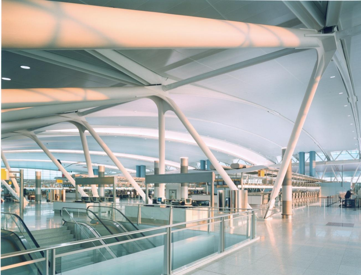
• Obr. 36 oceľová konštrukcia terminálu
