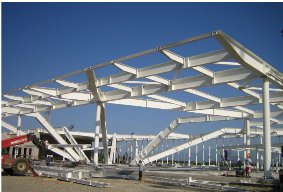
• Obr. 23 Oceľová konštrukcia
