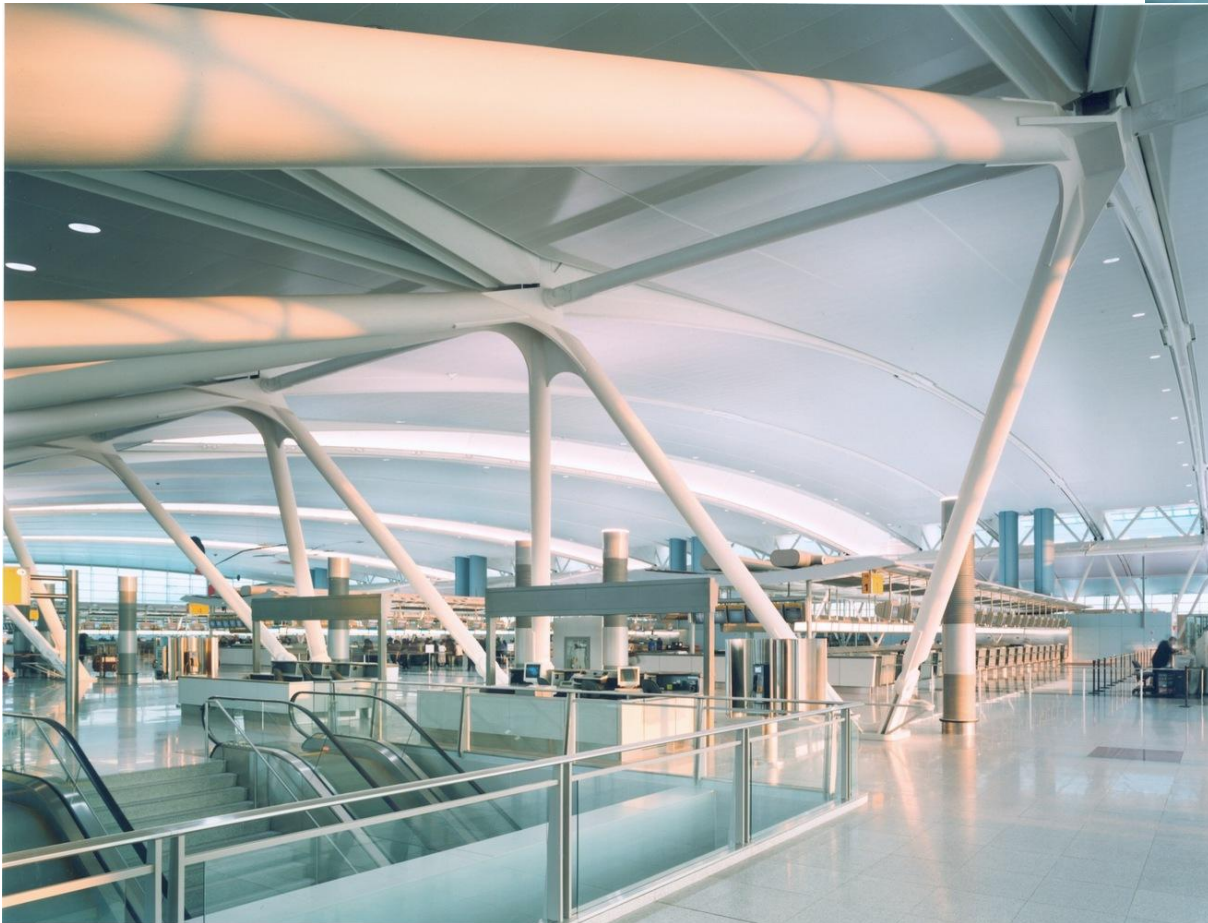
• Obr. 36 oceľová konštrukcia terminálu
