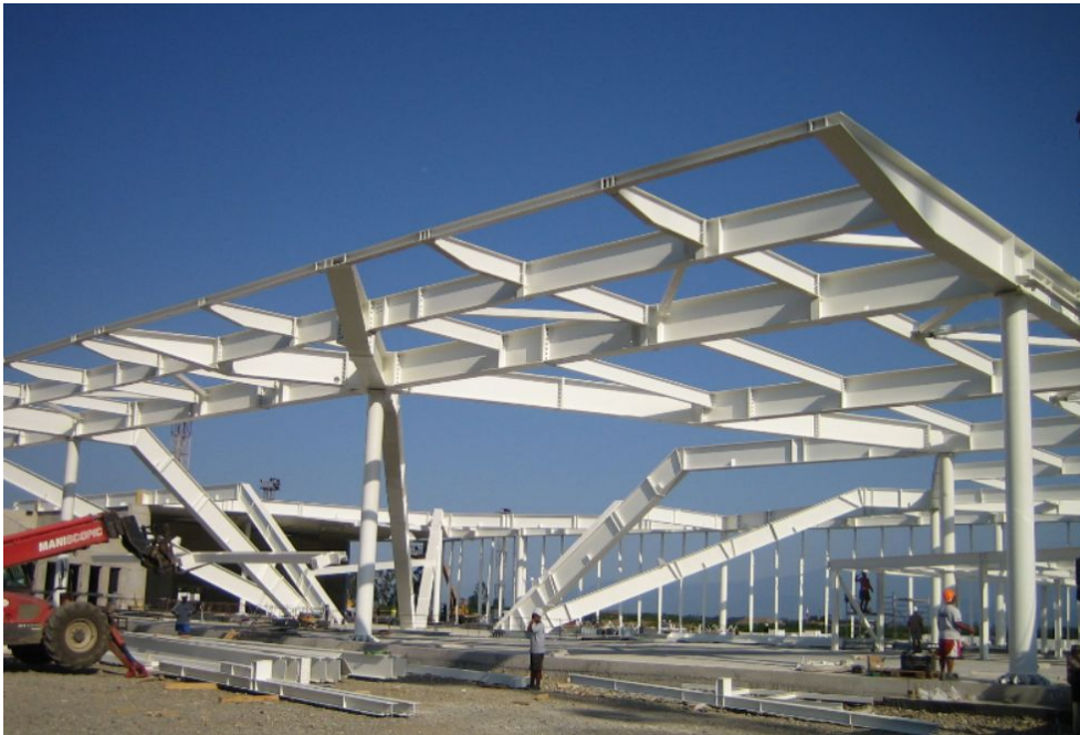
• Obr. 23 Oceľová konštrukcia
