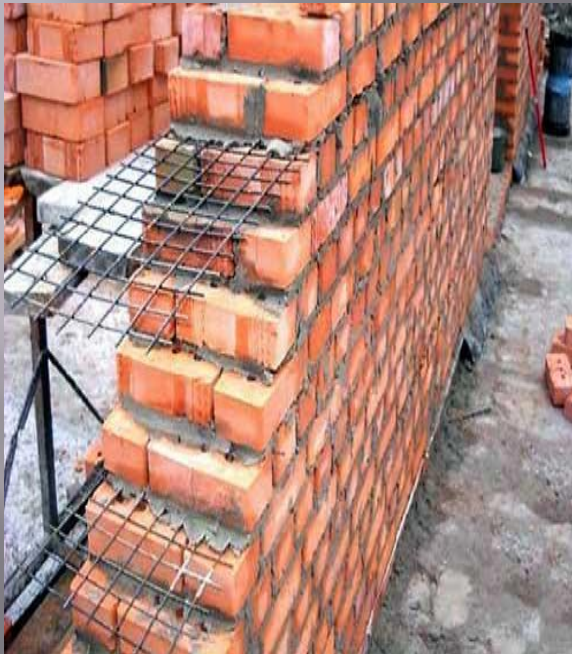
Рис. 60. Армирование кирпичных столбов прямоугольными (а) и зигзагообразными сетками (б) (1 – арматура)
