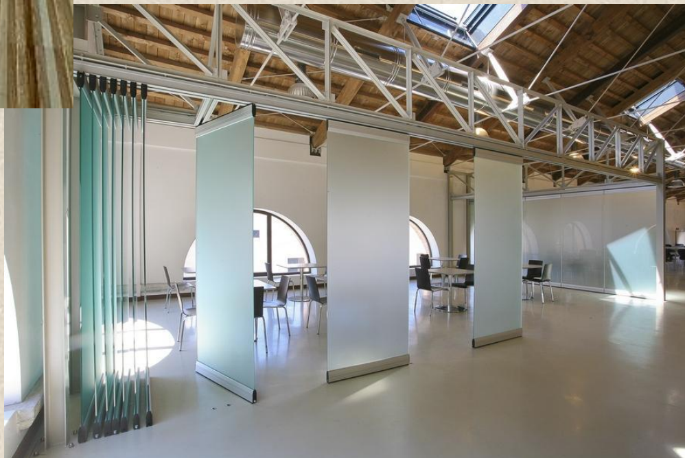
Трансформируемые стеклянные перегородки
