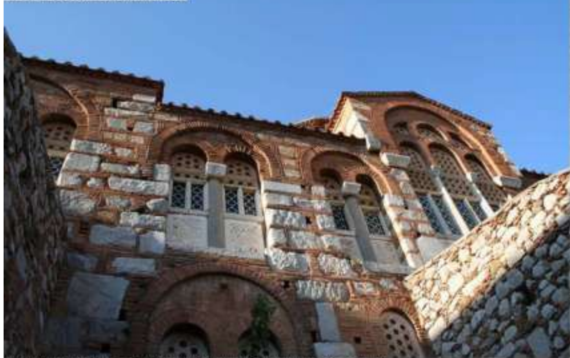
Кафаликон (1040-е годы), вид на кладку стен (обрамление бесполосных квадратов пилефой)
